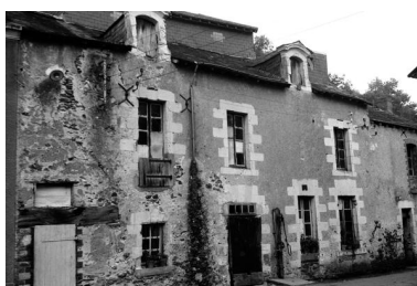
Façade principale du logis du moulin à eau de Châteaupanne, Montjean-sur-Loire. Phot. Marie-Anne Eon IVR52_19724900389Z
