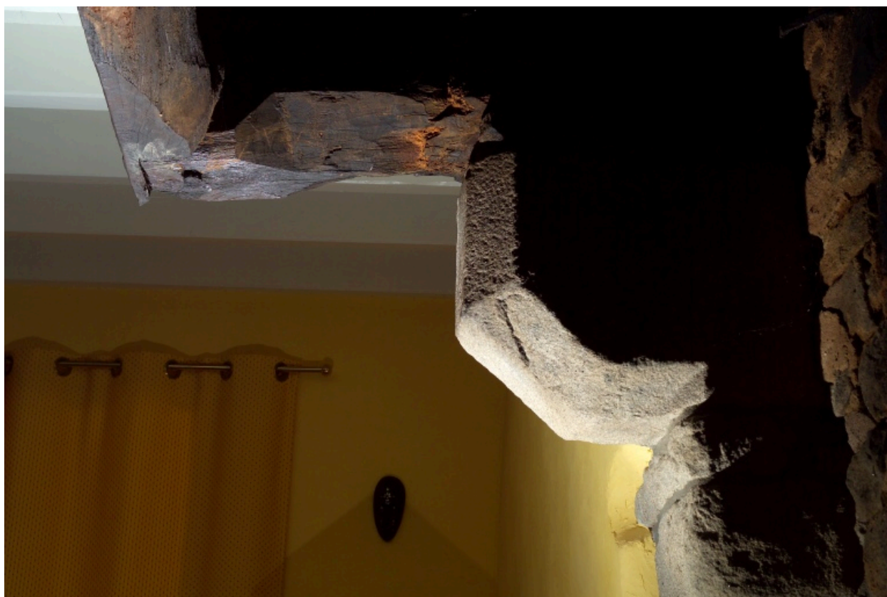
Cheminée de la partie ouest, détail.
