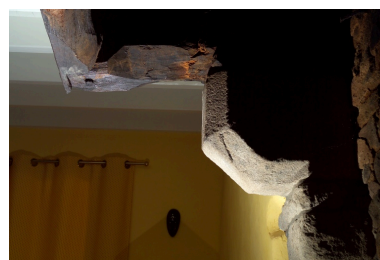
Cheminée de la partie ouest, détail. Phot. Denis Pillet IVR52_20074400723NUCA
