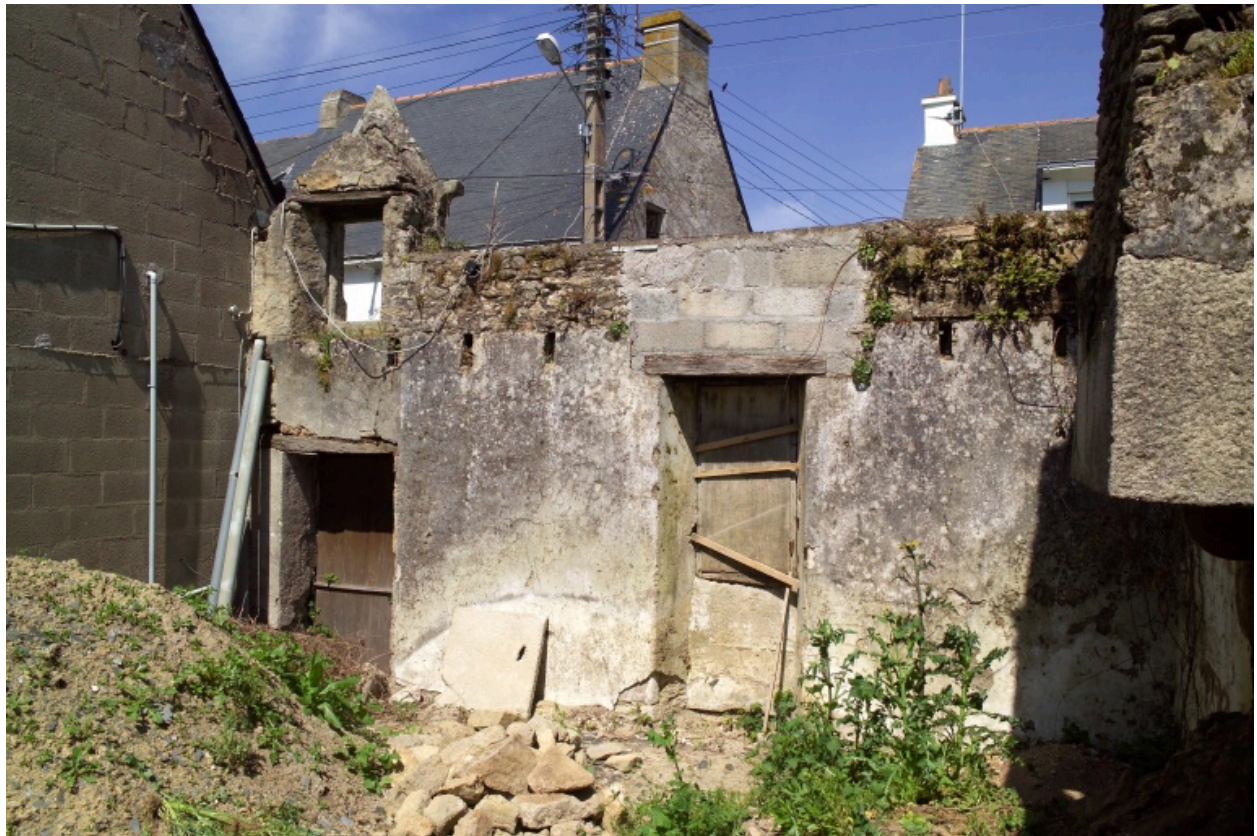
Partie est, parement interne de la façade.
