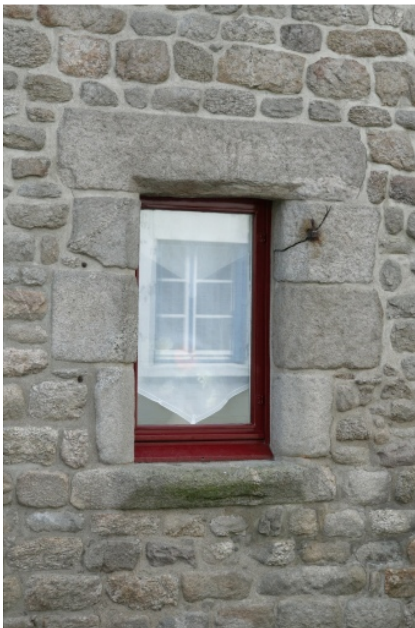
Façade sur rue, détail d'une fenêtre.
