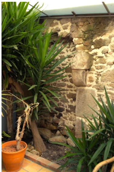
Cheminée de l'extension contre la partie orientale.
