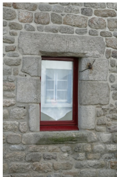
Façade sur rue, détail d'une fenêtre. Phot. Denis Pillet IVR52_20064403096NUCA
