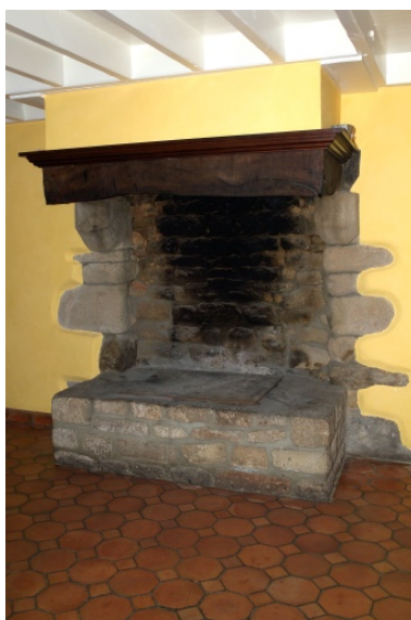
Cheminée de la partie ouest. Phot. Denis Pillet IVR52_20074400722NUCA
