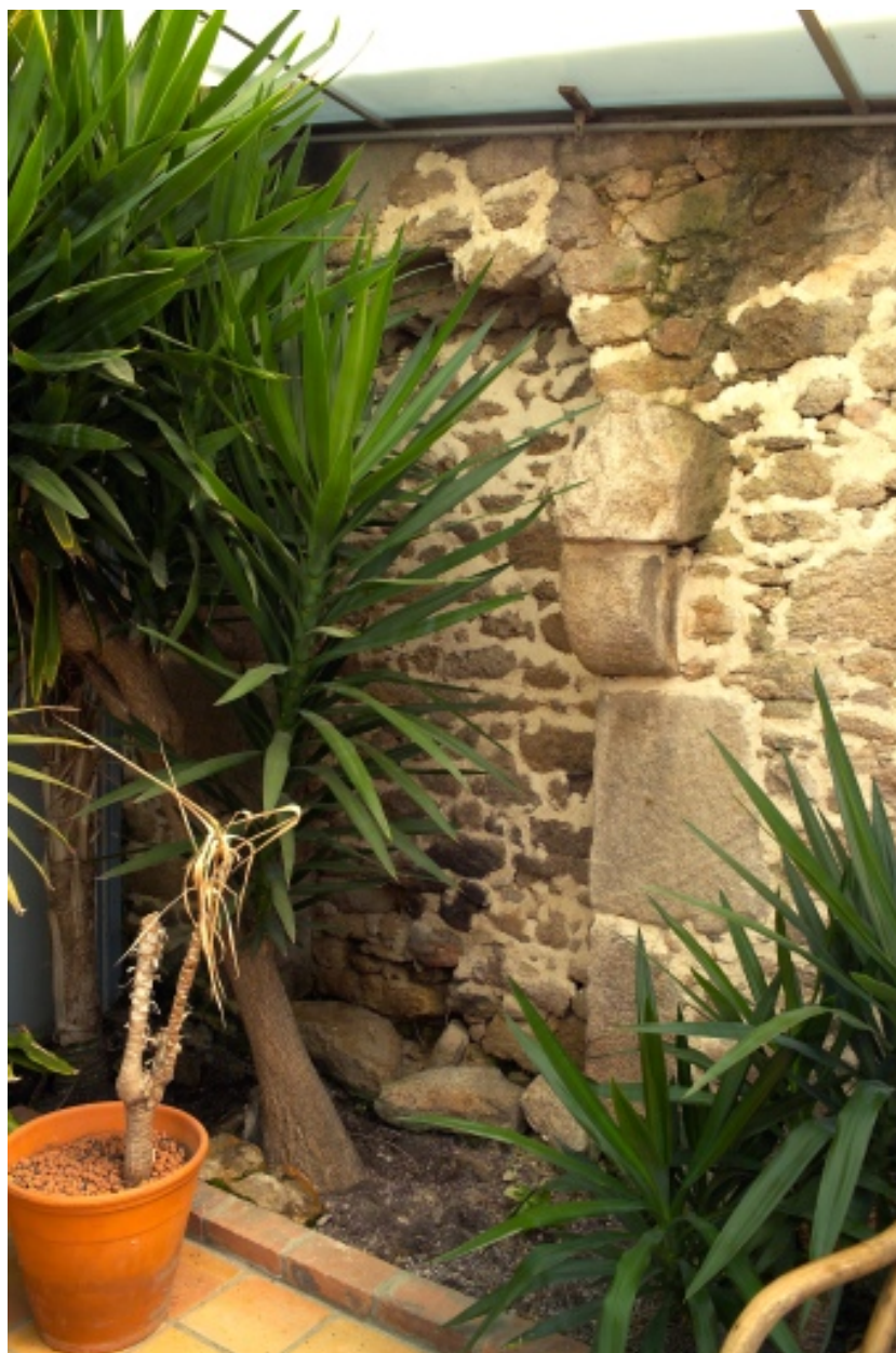
Cheminée de l'extension contre la partie orientale.
