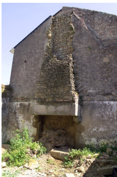
Cheminée de la partie est. Phot. Denis Pillet IVR52_20074400725NUCA
