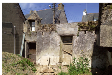
Partie est, parement interne de la façade. Phot. Denis Pillet IVR52_20074400728NUCA
