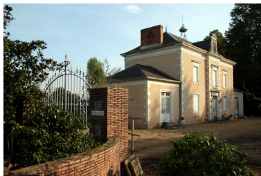
Façade antérieure sur cour. Phot. Jean-Baptiste Darrasse IVR52_20067207500NUCA
