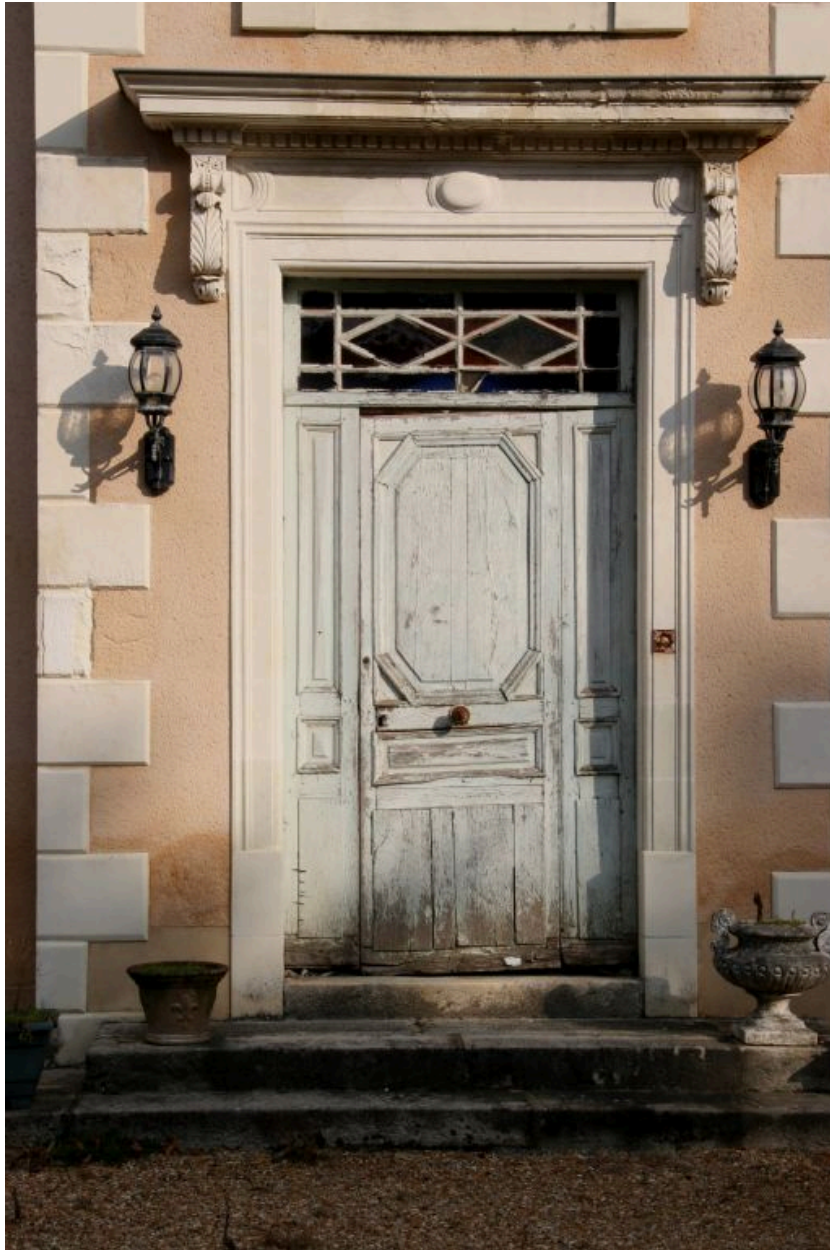
Façade antérieure sur cour : la porte d'entrée.
