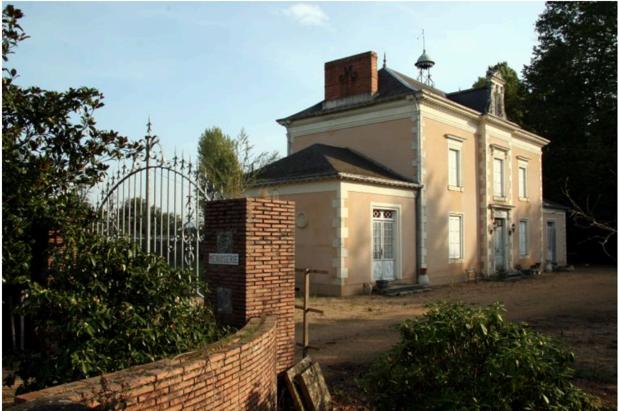
Façade antérieure sur cour.
