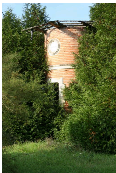
Dans le jardin : tourelle en brique. Phot. Jean-Baptiste Darrasse IVR52_20067207505NUCA
