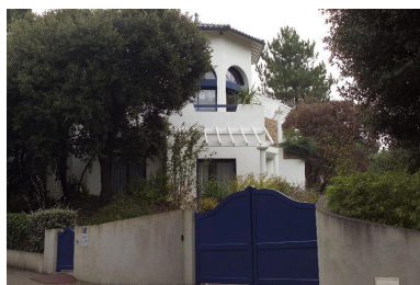
Vue d'ensemble de la villa Ker Vir.
