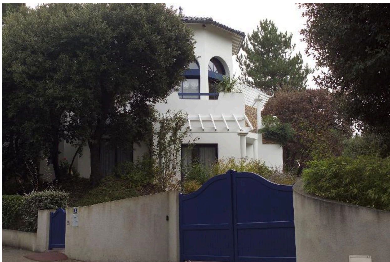
Vue d'ensemble de la villa Ker Vir.
