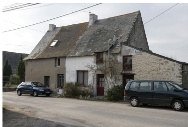
Vue d'ensemble depuis le nord-est. Phot. Denis Pillet IVR52_20084400112NUCA
