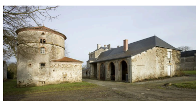
Le pigeonnier et l'orangerie. 19e siècle. Phot. Yves Guillotin IVR52_20114400084NUCA
