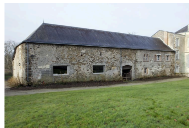
L'aile sud, remaniée au 19e siècle. Le passage charretier date du 18e siècle. Phot. Yves Guillotin IVR52_20114400077NUCA
