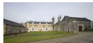
La cour : vue d'ensemble à partir de l'est. Phot. Yves Guillotin IVR52_20114400090NUCA
