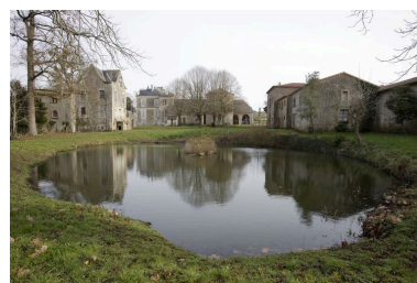
La cour des communs : vue d'ensemble à partir du sud. Phot. Yves Guillotin IVR52_20114400092NUCA
