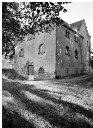
La grange : détail des ouvertures et porte fanière murée. Phot. Denis Pillet IVR52_19974402971X
