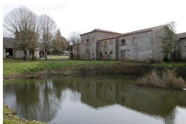
Bâtiment des écuries : vue d'ensemble de la façade ouest. Phot. Yves Guillotin IVR52_20114400093NUCA
