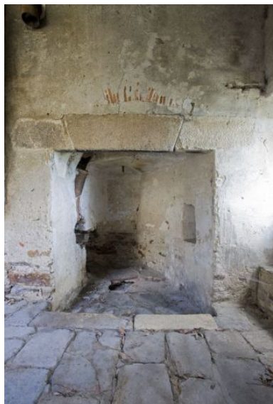
La buanderie : intérieur. Phot. Yves Guillotin IVR52_20114400107NUCA
