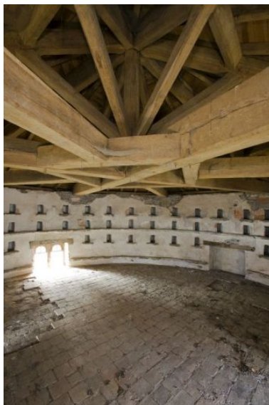
Le pigeonnier : détail des trous de boulin et de la charpente. Phot. Yves Guillotin IVR52_20114400108NUCA
