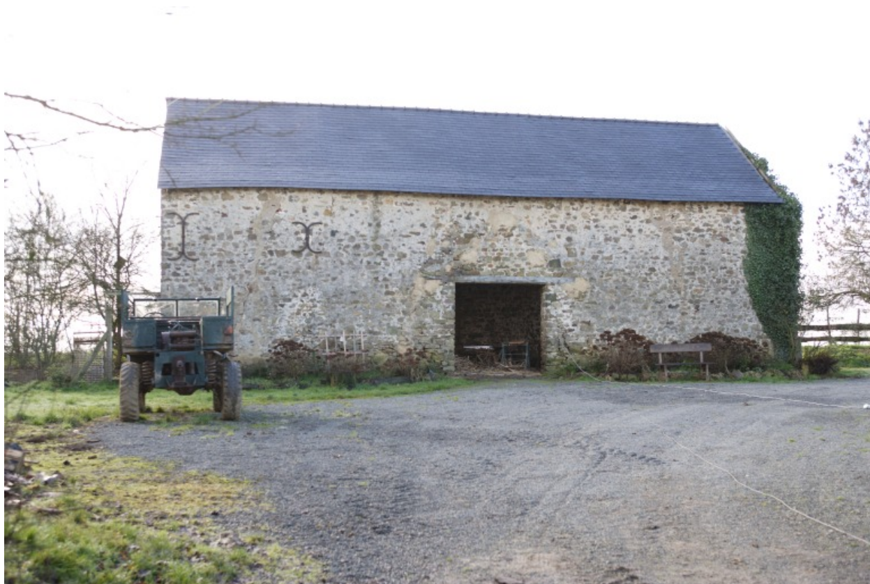
La remise vue depuis le nord.
