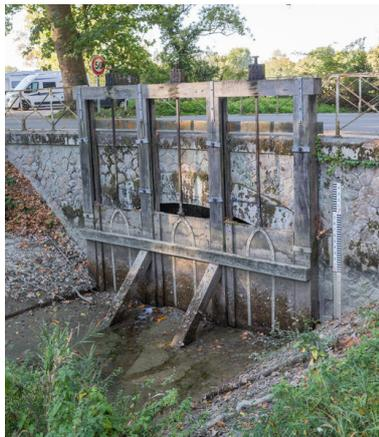
Vanne triple de régulation hydraulique dit du "canal d'irrigation".
