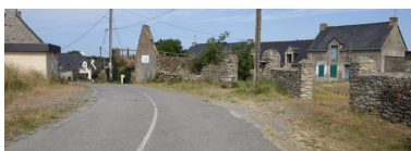
Vue d'ensemble depuis le sud-est. Phot. Denis Pillet IVR52_20084402104NUCA
