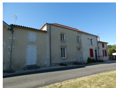
Le logis vu depuis le sud-ouest.
