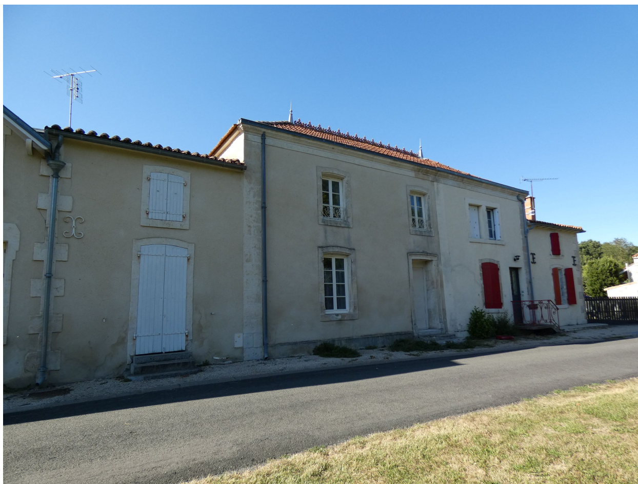
Le logis vu depuis le sud-ouest.
