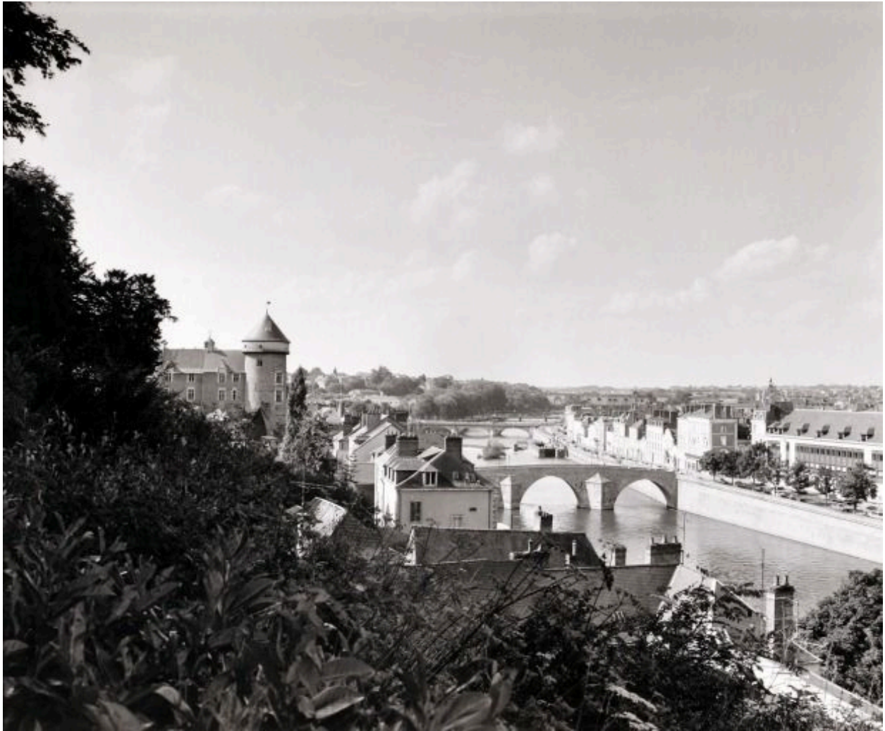
Vue d'ensemble de la Mayenne, du Vieux-Pont au viaduc.
