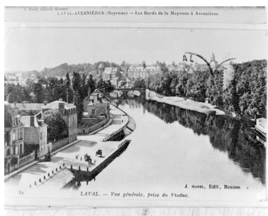
Carte postale ancienne ; La Mayenne en aval du viaduc, vue depuis le nord. Repro. Jacques Le Callonnec IVR52_19775300981X
