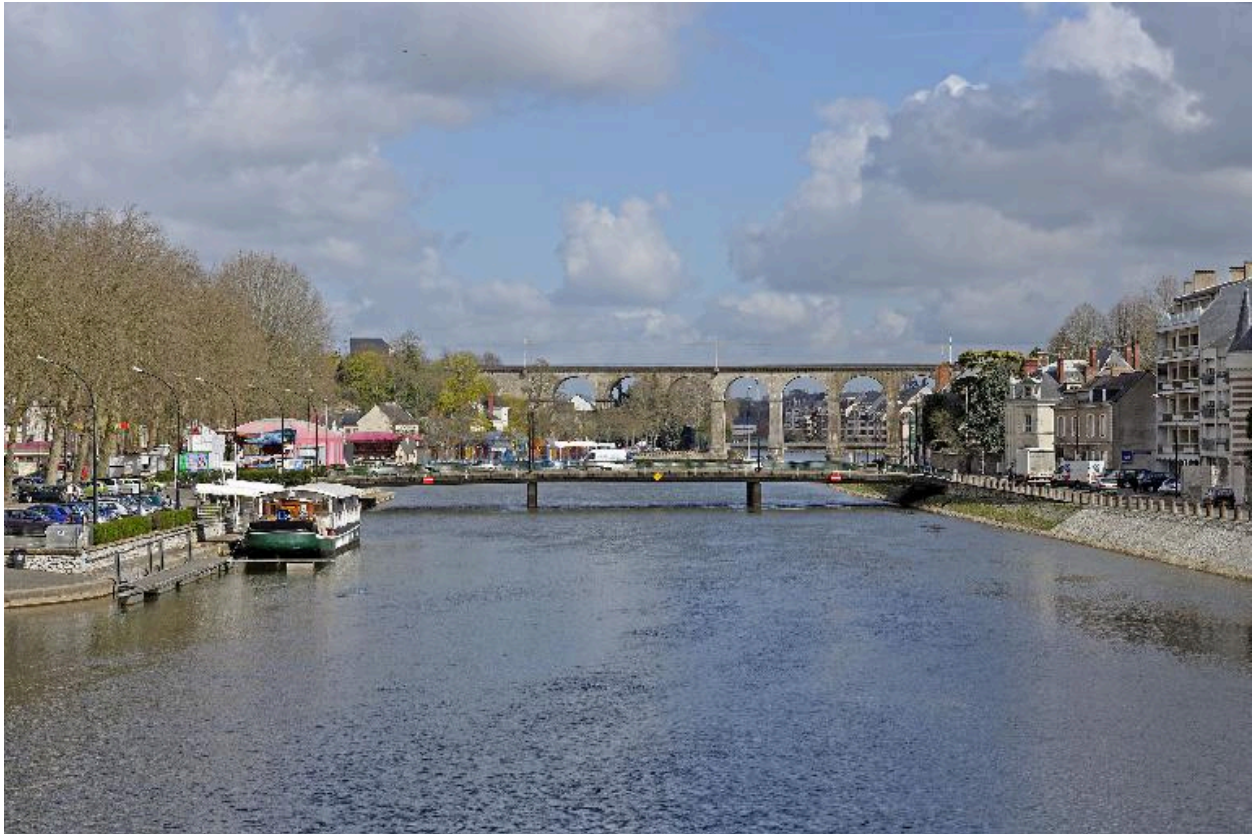
La Mayenne en amont du Pont-Neuf. Vue d'ensemble depuis le sud.
