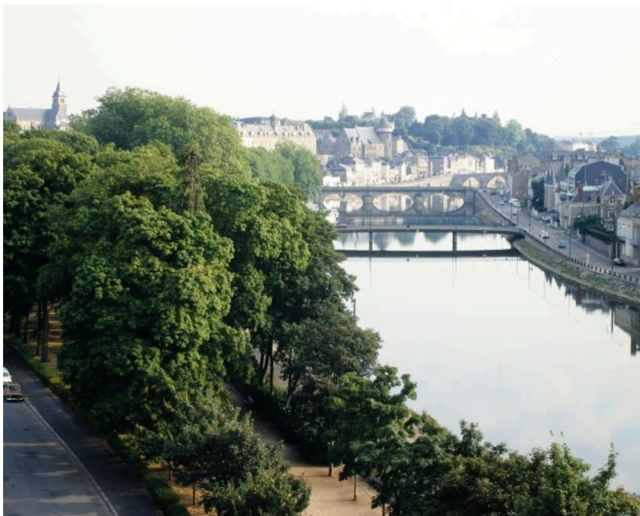
La Mayenne en aval du viaduc, vue depuis le nord.
