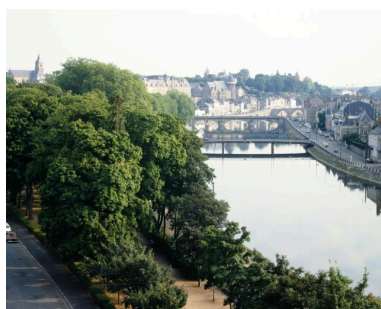
La Mayenne en aval du viaduc, vue depuis le nord. Phot. François Lasa IVR52_19885300326XA
