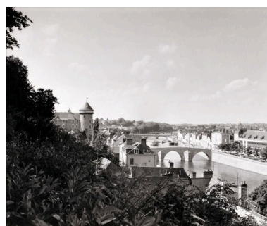
Vue d'ensemble de la Mayenne, du Vieux-Pont au viaduc. Phot. François Lasa IVR52_19895300304X
