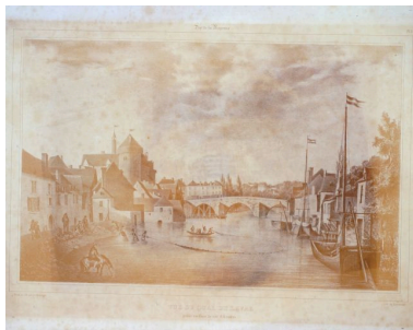
La Mayenne en aval du Vieux-Pont, vue depuis le sud. Autr. Jean-Baptiste Messenger, Repr. François Lasa IVR52_19905300009XA
