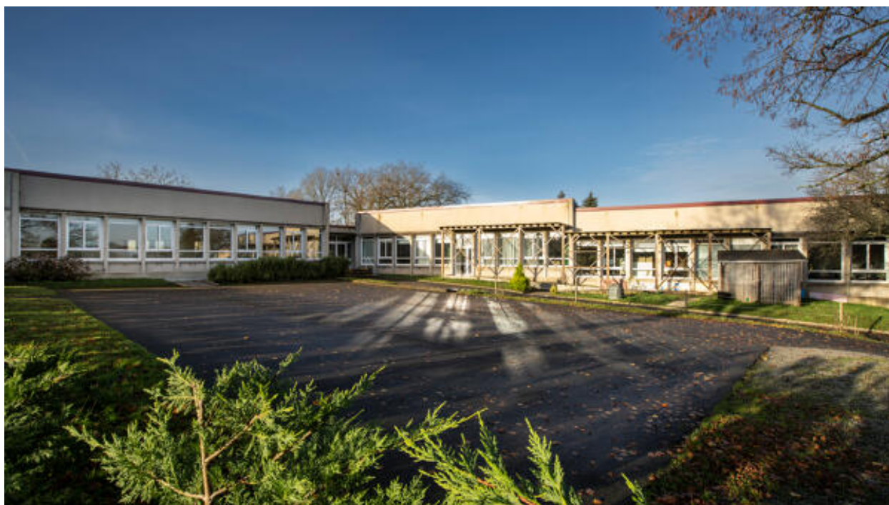
Vue d'ensemble avec la cour.
