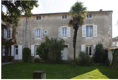
Façade nord de la maison, donnant sur le jardin. Phot. Patrice Giraud IVR52_20088501252NUCA
