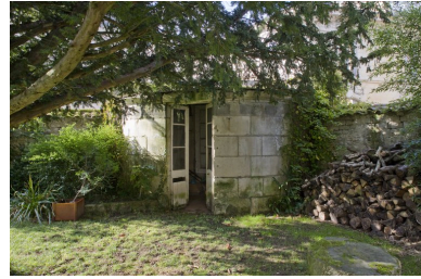
Pavillon à l'angle nord-ouest du jardin. Phot. Patrice Giraud IVR52_20088501254NUCA
