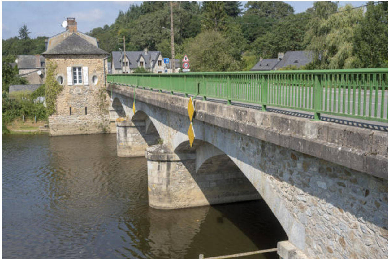
Le pont de Montgiroux.
