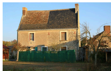
Façade sur cour. Phot. Jean-Baptiste Darrasse IVR52_20077202321NUCA
