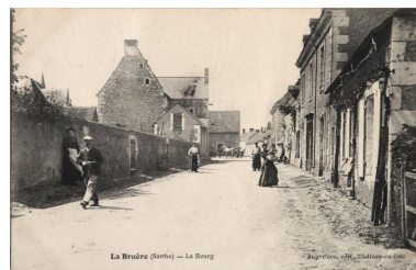
Vue d'ensemble prise de l'est : noter le mur de clôture en rive de rue. Autr. Auguste Cocu, Phot. Jean-Baptiste (reproduction) Darrasse IVR52_20067205389NUCA
