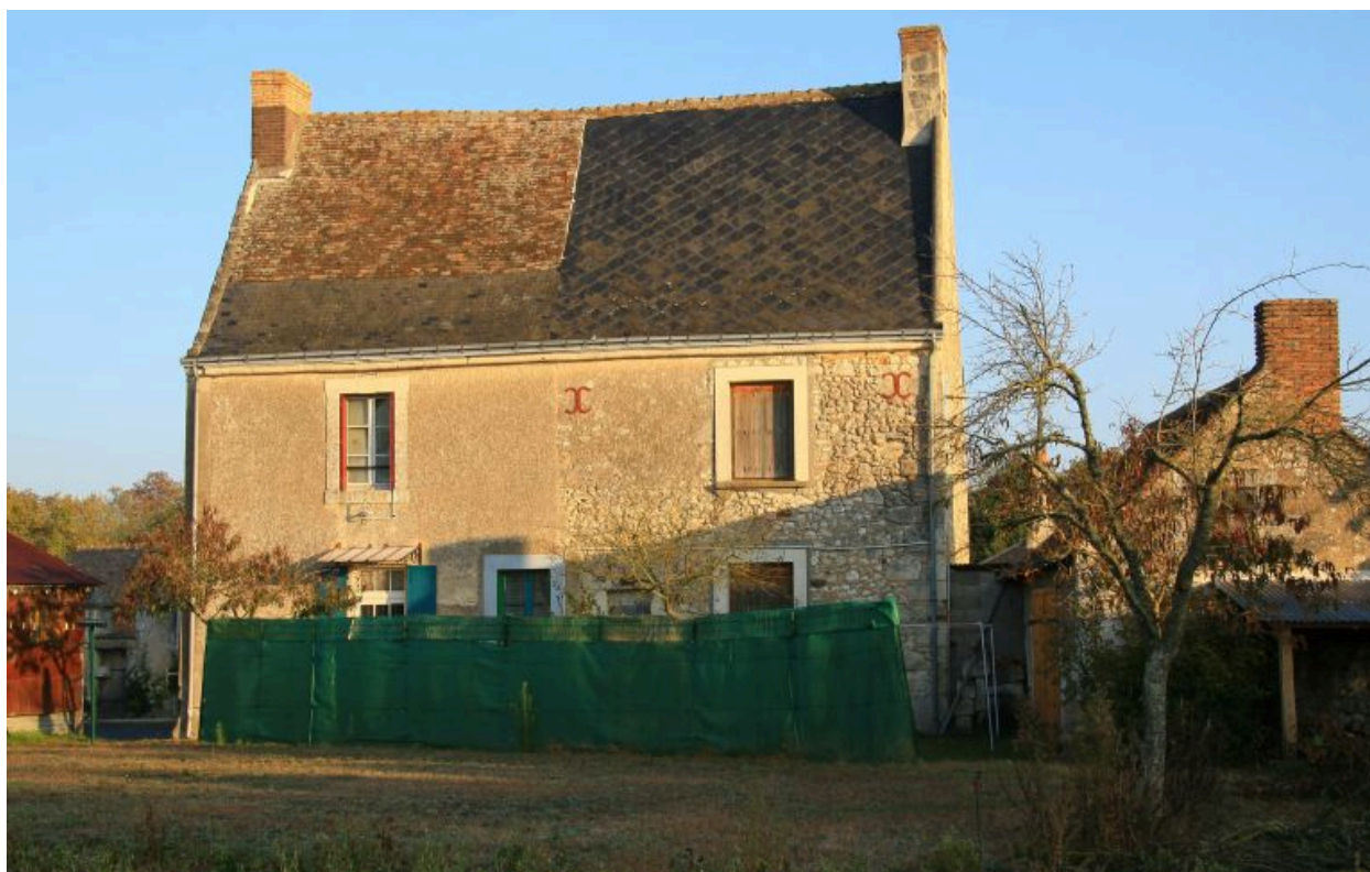
Façade sur cour.
