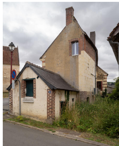
Vue arrière. Phot. Jeanne Minier IVR52_20257200332NUCA
