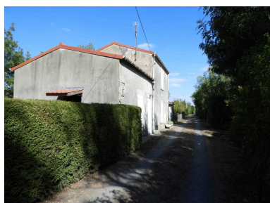
La hutte vue depuis l'ouest. Phot. Yannis Suire IVR52_20198500176NUCA
