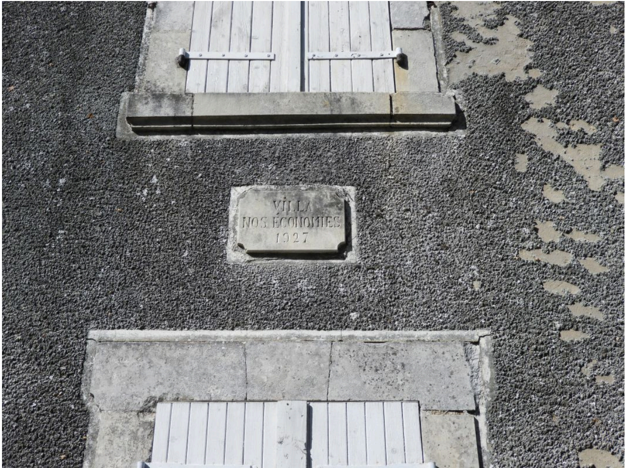
Détail de la façade : encadrements des ouvertures, cartouche portant la date et l'appellation.
