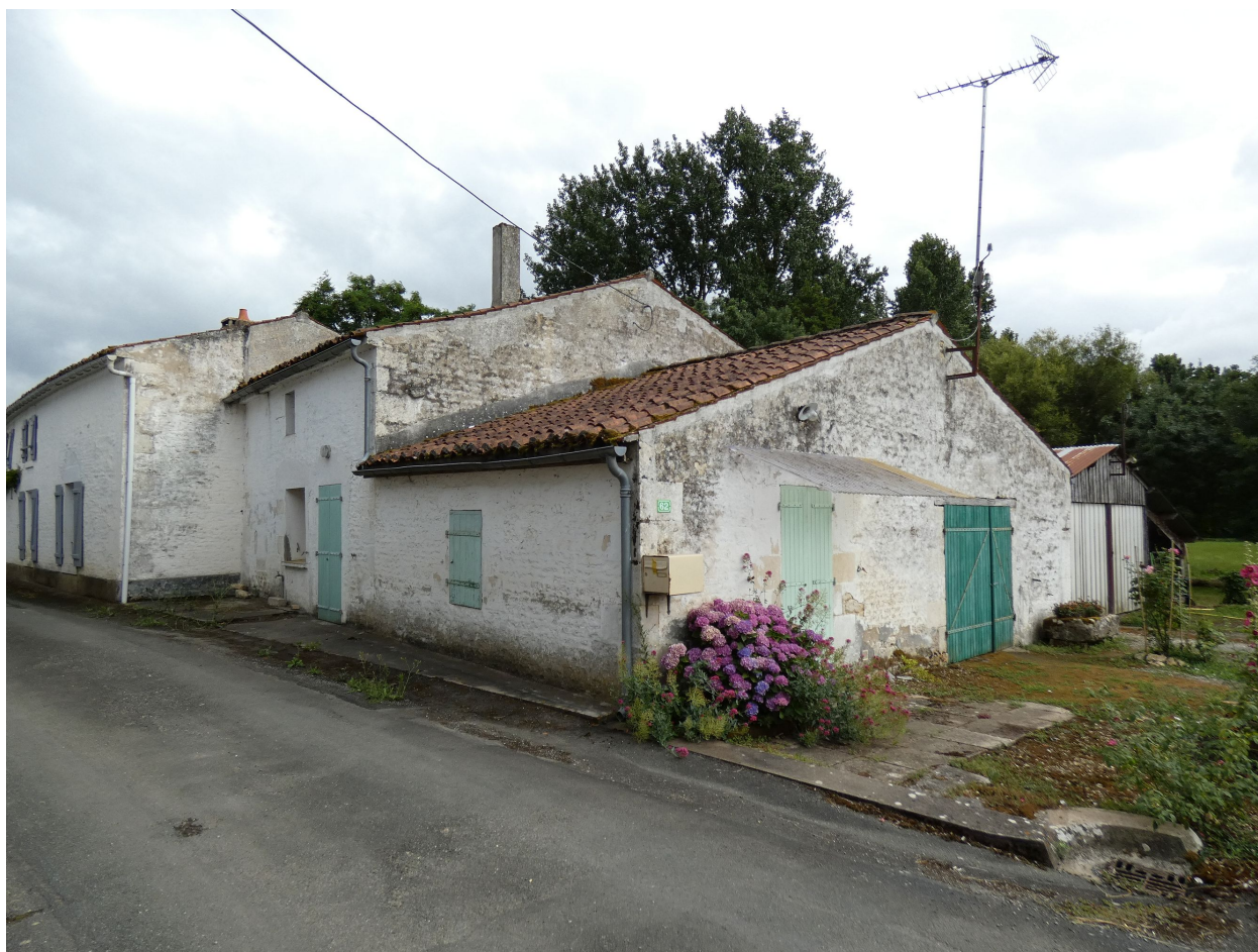
L'ancienne ferme vue depuis le nord-ouest.
