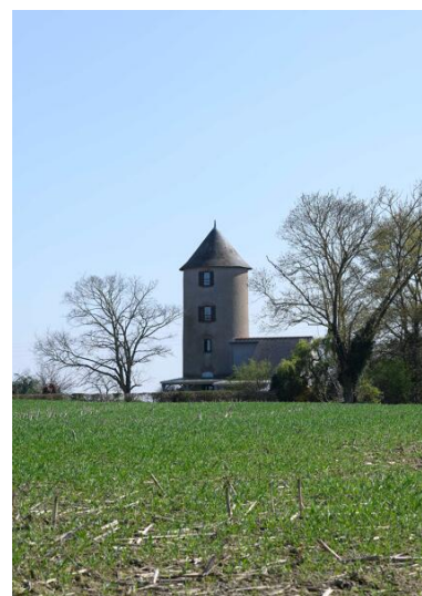
Moulin à farine dit le Moulin-Martin. Vue d'ensemble depuis le nord. Phot. Armelle Maugin IVR52_20254900393NUCA
