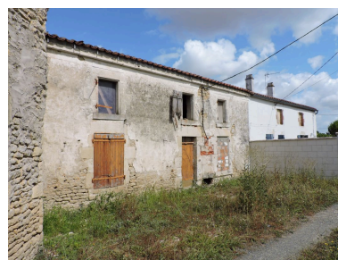
L'ancien logement (milieu du 19e siècle ?), en retour d'équerre à l'arrière de la grange-étable, vu depuis le sud.
