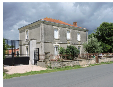
Le logis vu depuis le sud-ouest.
