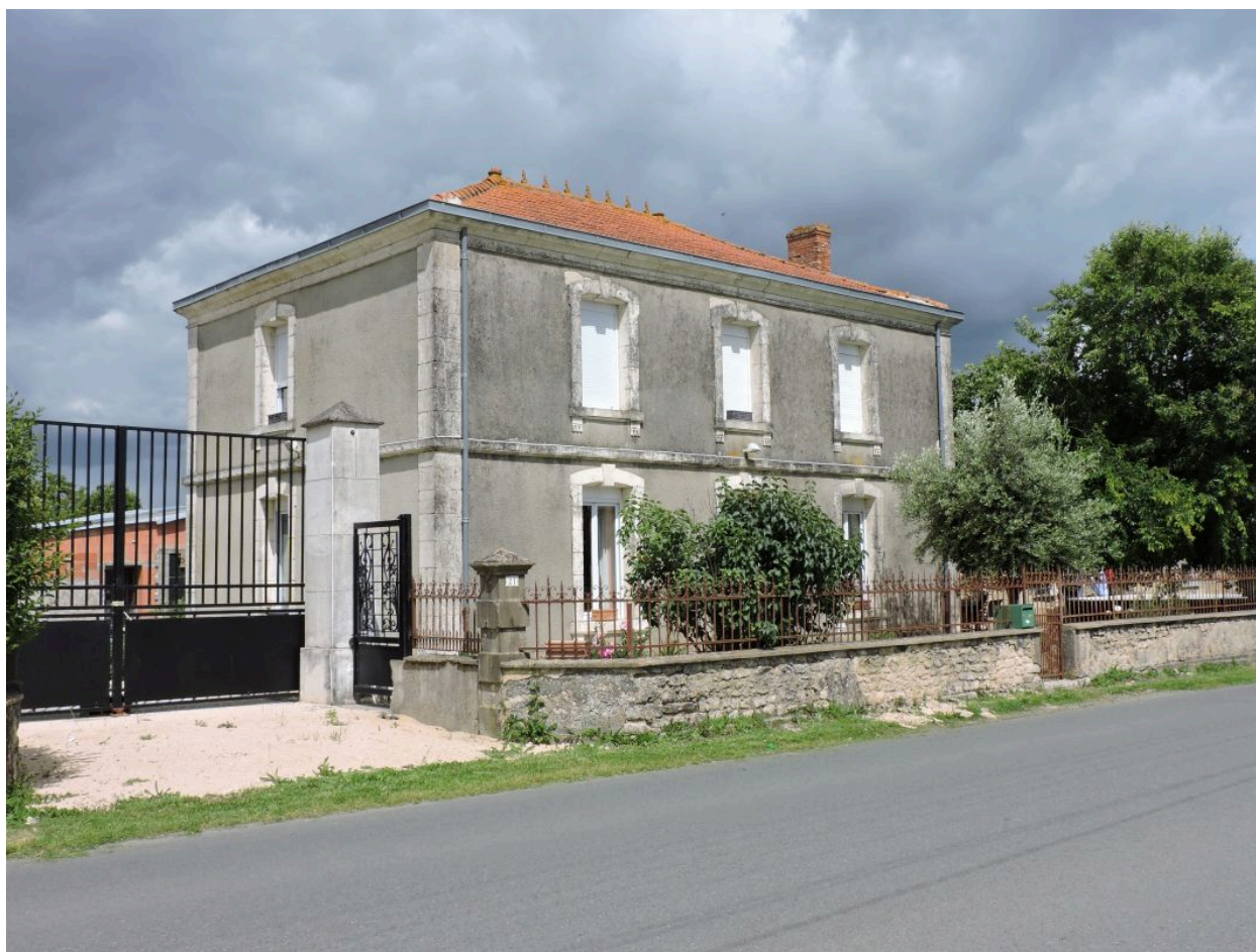
Le logis vu depuis le sud-ouest.
