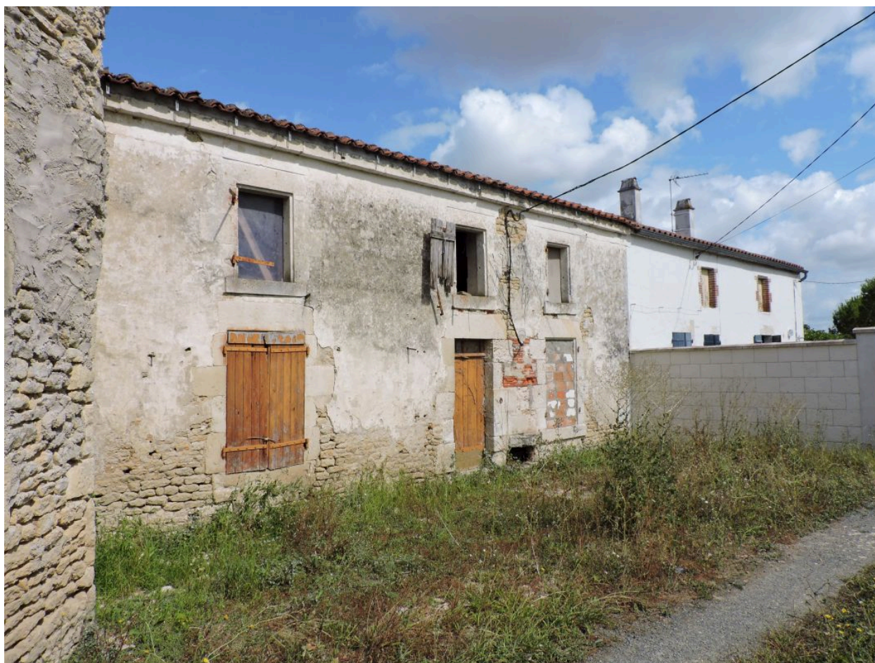
L'ancien logement (milieu du 19e siècle ?), en retour d'équerre à l'arrière de la grange-étable, vu depuis le sud.
