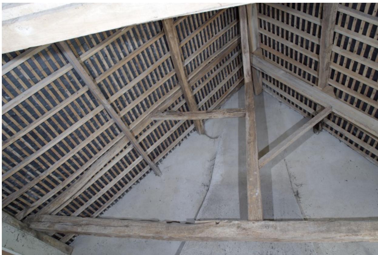
Comble : la ferme sud de la charpente vue depuis le nord.
