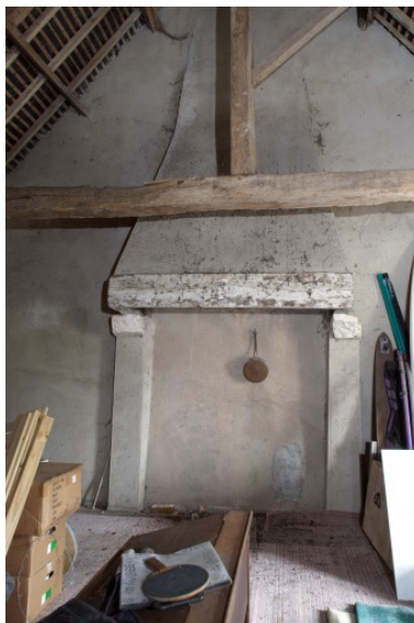
Comble : la cheminée vue depuis le nord.
