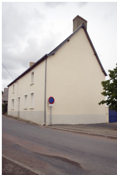
Vue depuis la route au sud-ouest.
