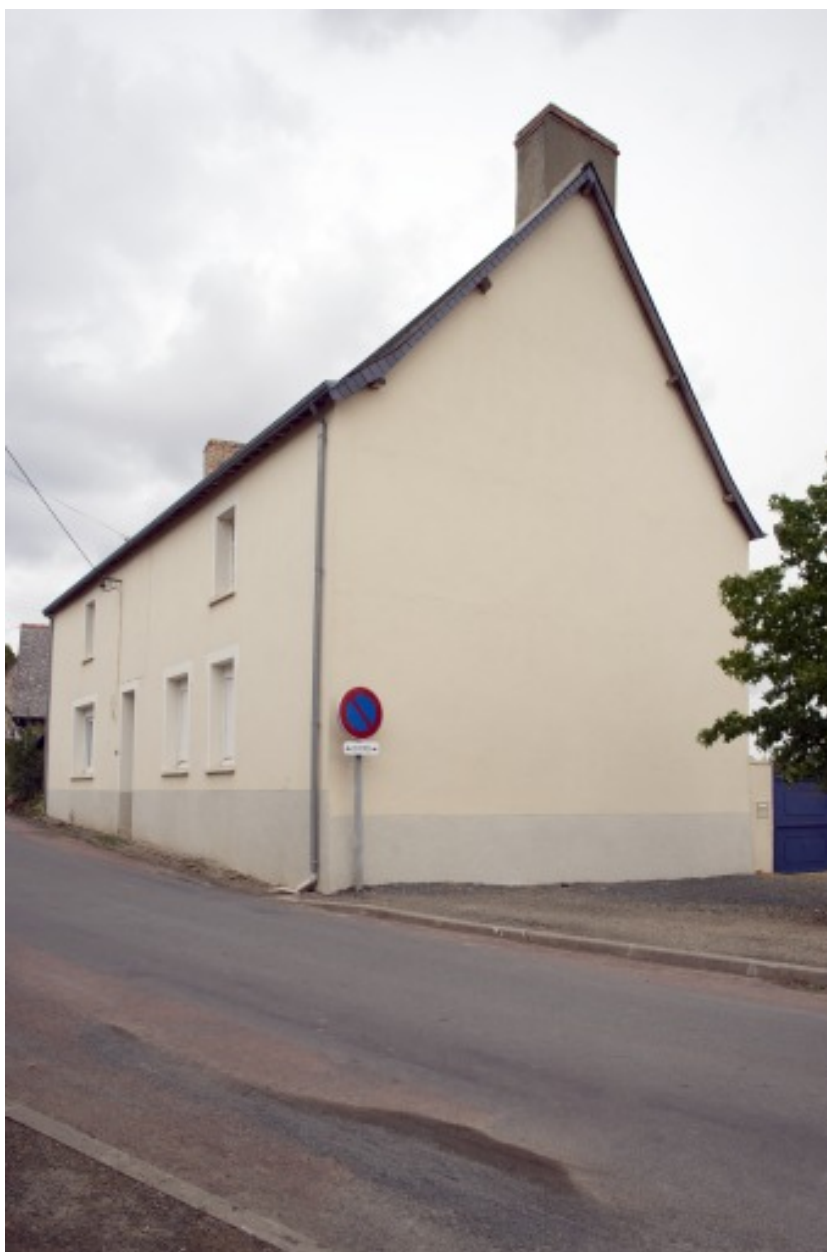
Vue depuis la route au sud-ouest.
