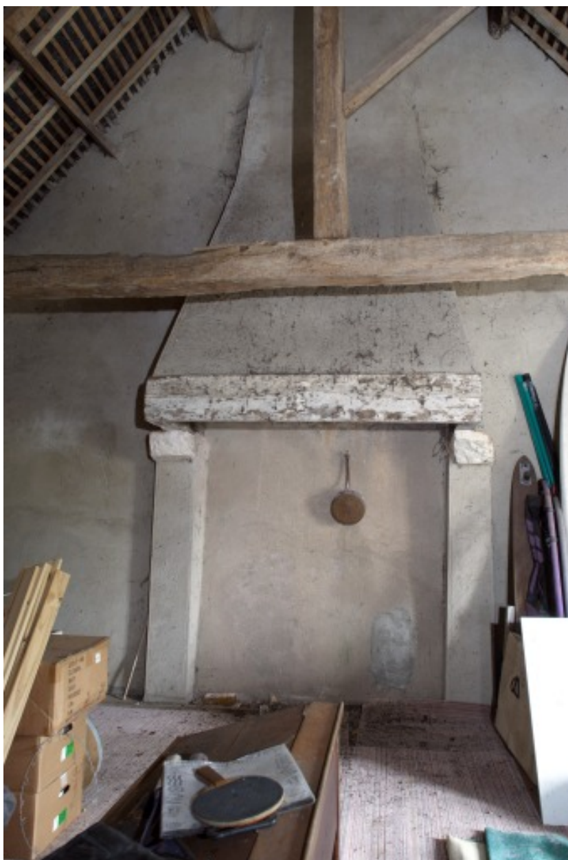
Comble : la cheminée vue depuis le nord.
