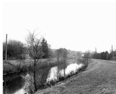
Partie sud du canal depuis la rive droite en amont. Au fond, l'écluse et la maison éclusière. Phot. François Lasa IVR52_20015300751X
