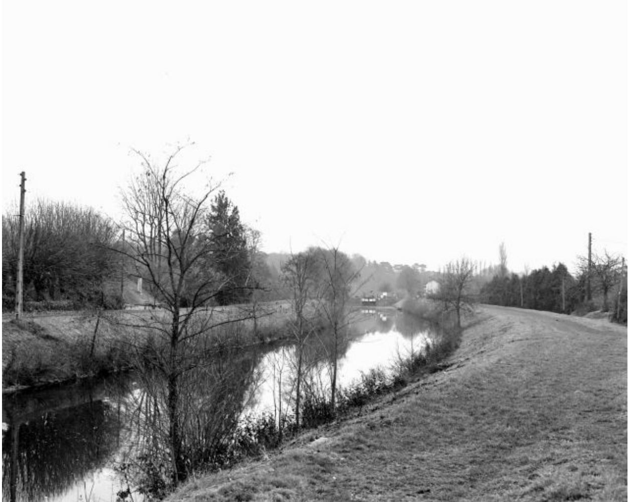
Partie sud du canal depuis la rive droite en amont. Au fond, l'écluse et la maison éclusière.
