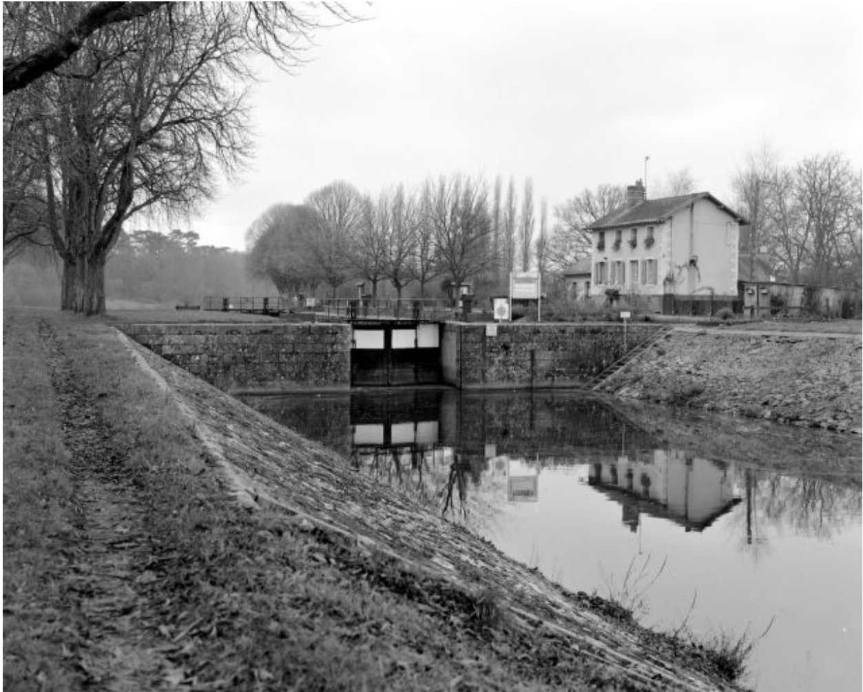
L'écluse et la maison éclusière vus depuis la digue en amont.
