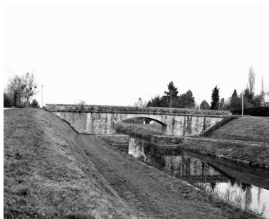
Le pont enjambant le canal depuis la rive droite en aval. Phot. François Lasa IVR52_20015300750X
