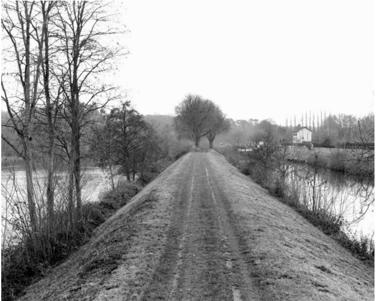
La Mayenne (à gauche) et la partie sud du canal (à droite) depuis la digue de séparation. Vue d'amont. Au fond à droite, l'écluse et la maison éclusière.
