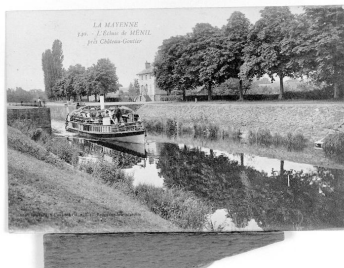
Le canal, l'écluse et la maison éclusière vus depuis l'aval. Phot. François Lasa IVR52_20015300379XB
