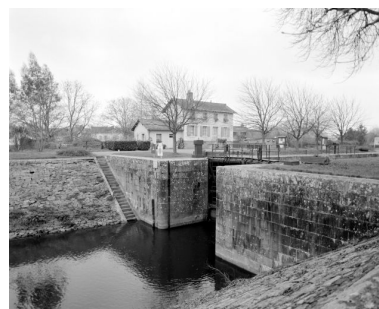
L'écluse et la maison éclusière vus depuis la digue en aval. Phot. François Lasa IVR52_20015300758X
