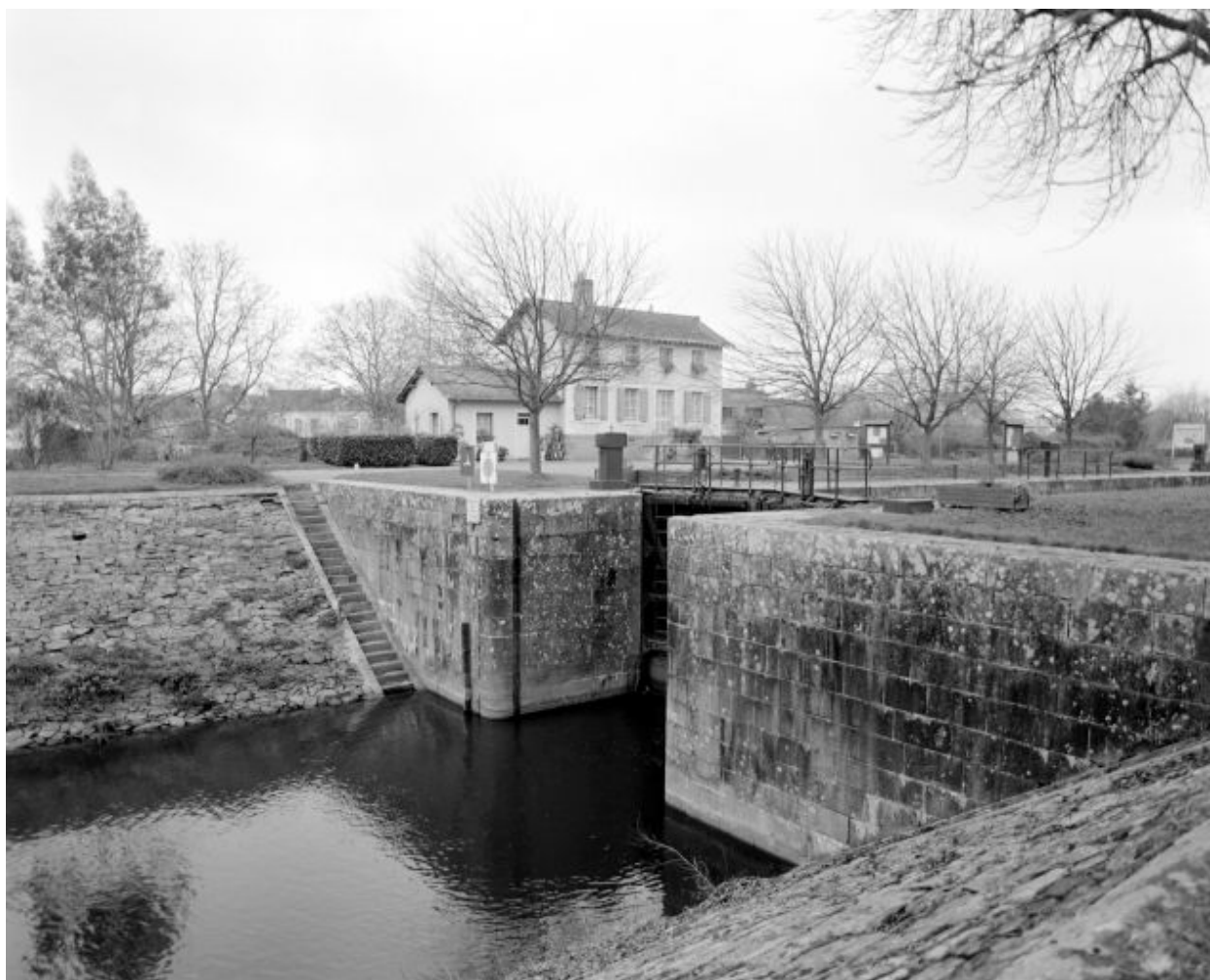
L'écluse et la maison éclusière vus depuis la digue en aval.
