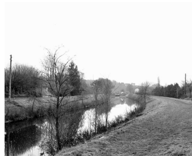
Partie sud du canal depuis la rive droite en amont. Au fond, l'écluse et la maison éclusière. Phot. François Lasa IVR52_20015300751X
