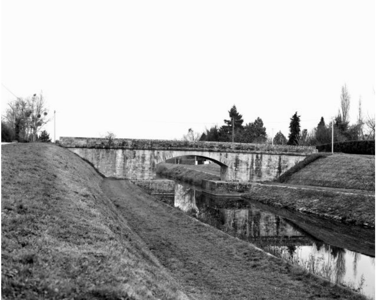
Le pont enjambant le canal depuis la rive droite en aval.
