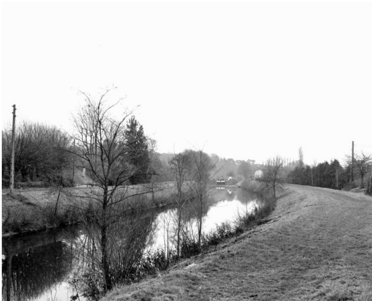
Partie sud du canal depuis la rive droite en amont. Au fond, l'écluse et la maison éclusière.
