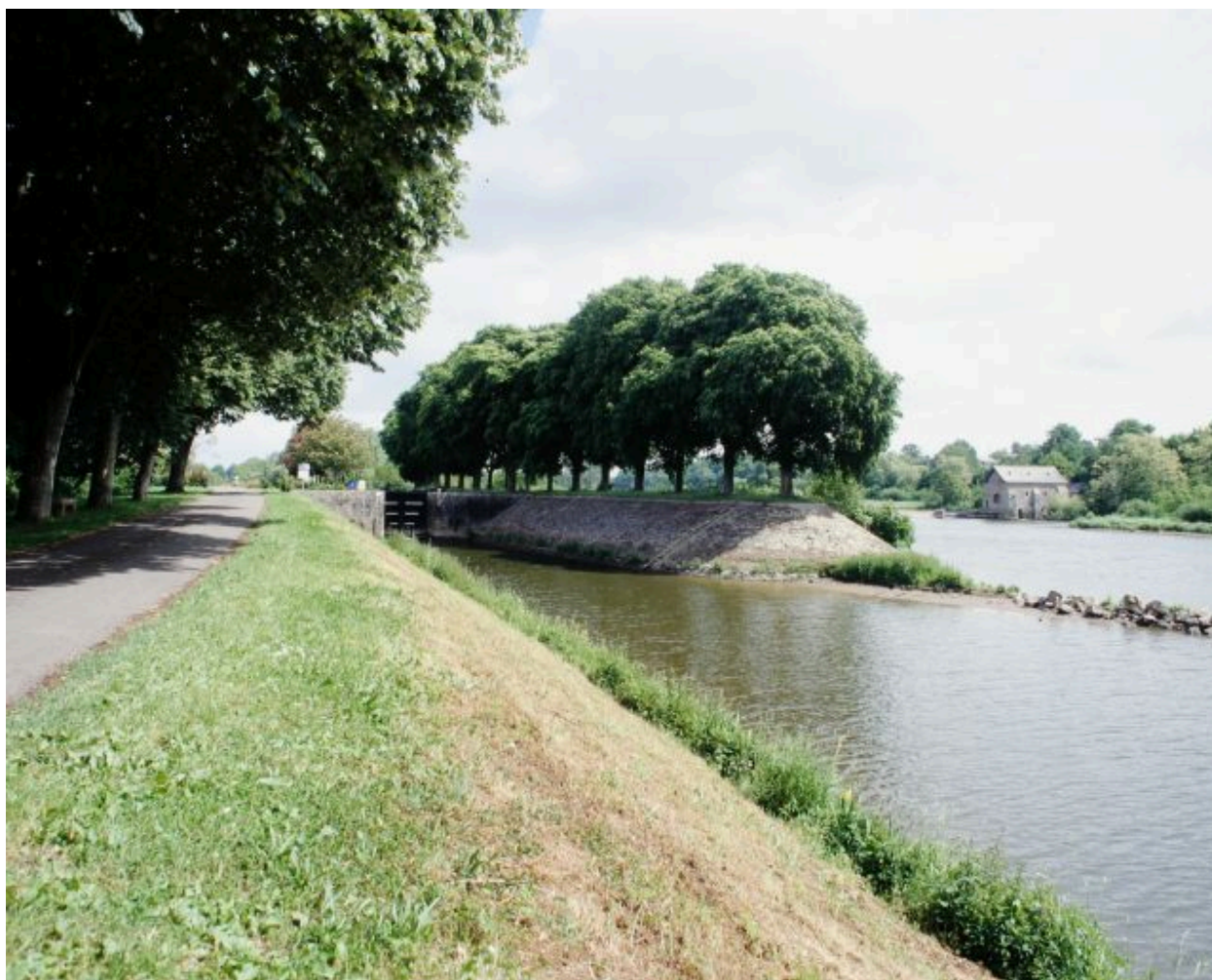
La sortie du canal, l'écluse, la digue, la Mayenne et le moulin du Gué vus depuis la rive droite en aval.
