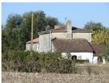
L'ancienne ferme vue depuis l'est. Phot. Yannis Suire IVR52_20198500428NUCA
