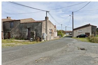
La rue de la Sèvre, vers la place des Mortiers. Phot. Yves Guillotin IVR52_20114400758NUCA
