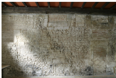
Intérieur du chais : vue du mur ouest, montrant les reprises successives de la construction. Phot. Patrice Giraud IVR52_20078500112NUCA
