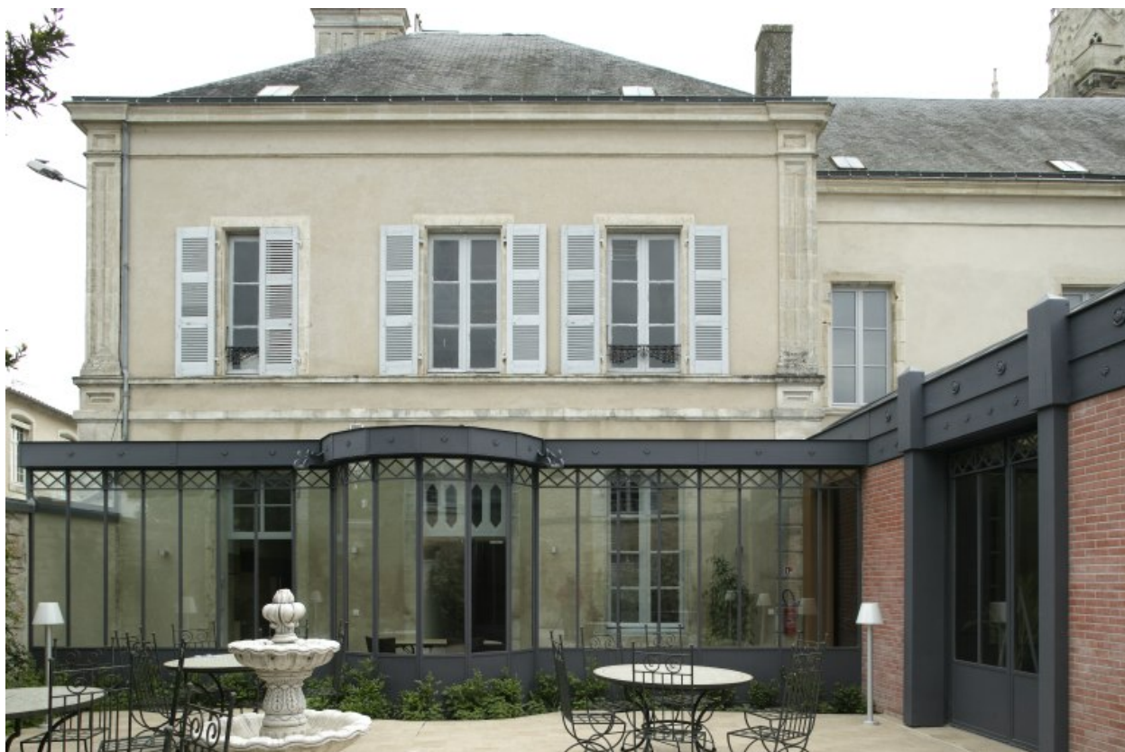
Façade postérieure de la maison Vrignaud (vue prise de la première cour).
