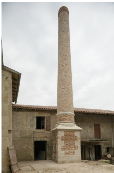
Cheminée de la distillerie, dans la seconde cour. Phot. Patrice Giraud IVR52_20078500130NUCA
