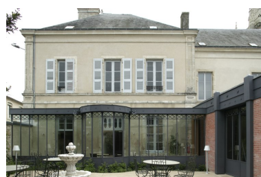
Façade postérieure de la maison Vrignaud (vue prise de la première cour). Phot. Patrice Giraud IVR52_20078500114NUCA
