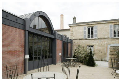
Vue prise de la première cour. A gauche la salle de réception, à droite la maison canoniale. Phot. Patrice Giraud IVR52_20078500113NUCA
