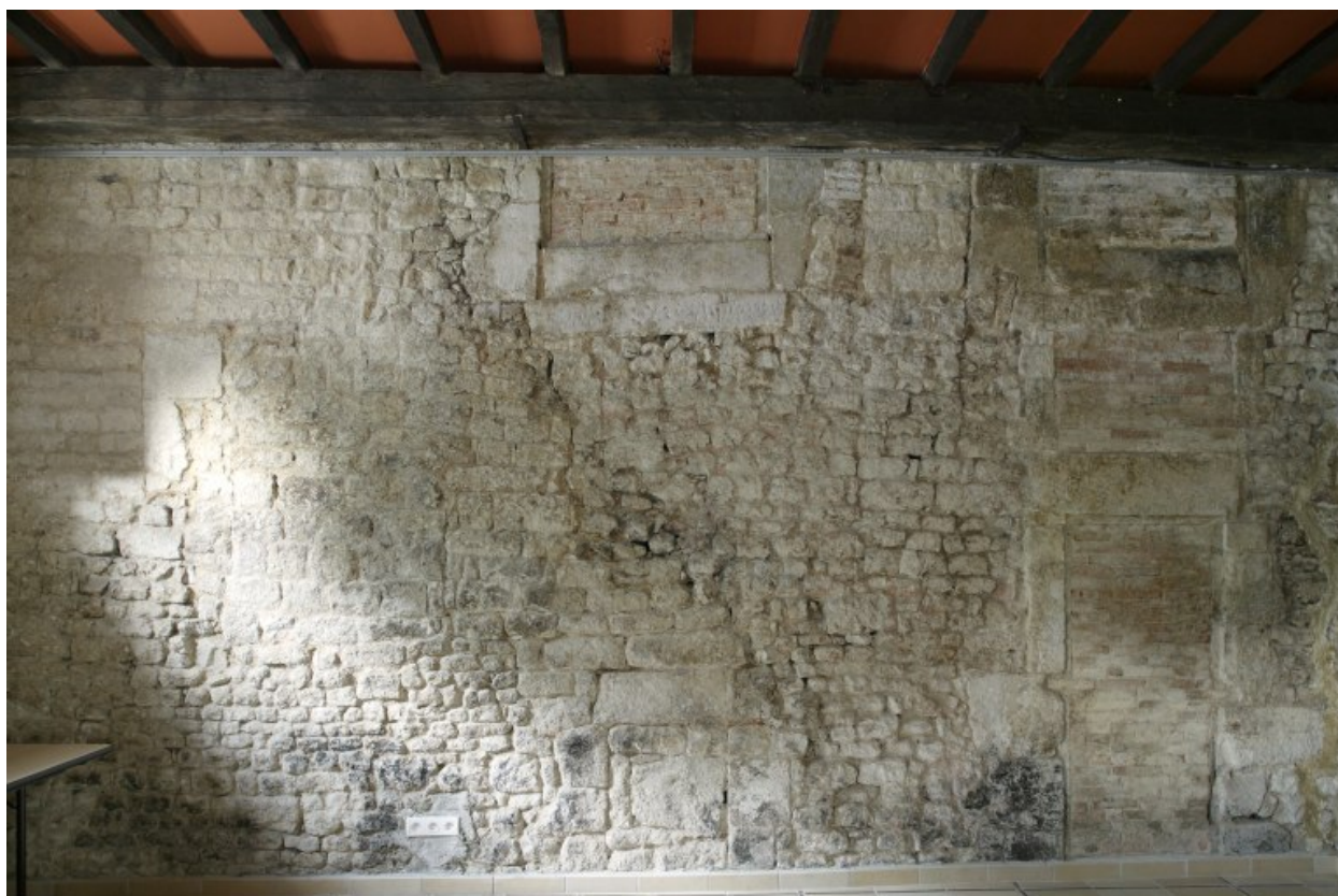
Intérieur du chais : vue du mur ouest, montrant les reprises successives de la construction.
