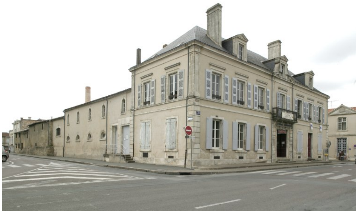
Vue d'ensemble prise du sud-est.
