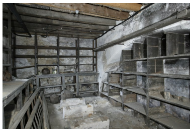
Magasin, au sous-sol de la maison Vrignaud. Phot. Patrice Giraud IVR52_20078500117NUCA
