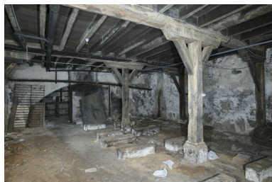
Magasin, au sous-sol de la maison Vrignaud. Phot. Patrice Giraud IVR52_20078500116NUCA
