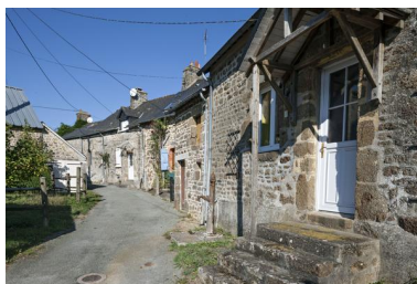
Alignement de trois maison (ZC 28-30). Phot. Yves Guillotin IVR52_20185300441NUCA
