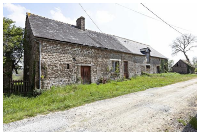
Alignement (223 ZC 21). Phot. Yves Guillotin IVR52_20215300260NUCA
