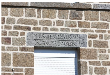
Maison (2023 ZC 105), linteau portant l'inscription "I RAIMBAULT RENEE OGER". Phot. Yves Guillotin IVR52_20185300438NUCA
