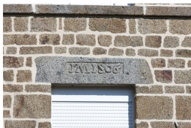
Maison (2023 ZC 105), linteau portant l'inscription "IM 1806". Phot. Yves Guillotin IVR52_20185300437NUCA
