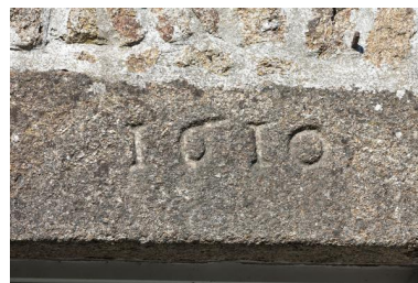
Alignement de trois maison (ZC 28-30), date portée 1610 sur le linteau de la maison ouest. Phot. Yves Guillotin IVR52_20185300463NUCA
