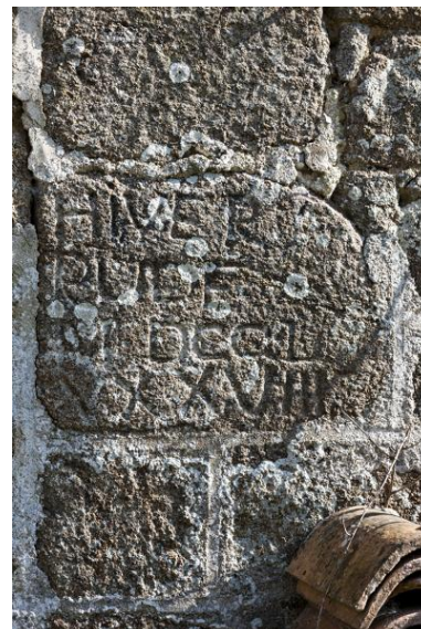
Inscriptions sur l'encadrement de la porte du logis gauche de l'alignement sud du village (2023 ZC 21) : "HIVER RUDE 1788". Phot. Yves Guillotin IVR52_20185300466NUCA
