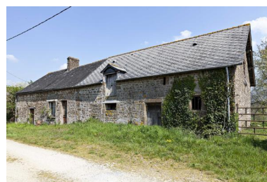
Alignement (223 ZC 21). Phot. Yves Guillotin IVR52_20215300259NUCA
