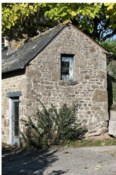
Fournil (2023 ZC 40). Phot. Yves Guillotin IVR52_20185300439NUCA
