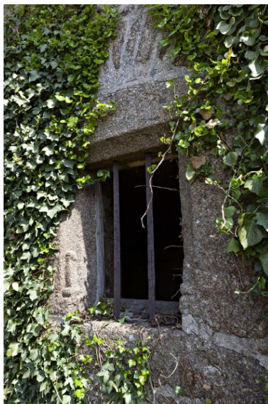
Alignement (223 ZC 21), fenêtre du logis sud. Phot. Yves Guillotin IVR52_20215300257NUCA
