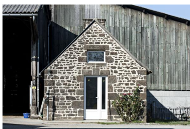
Remise (2023 ZC 132). Phot. Yves Guillotin IVR52_20185300444NUCA
