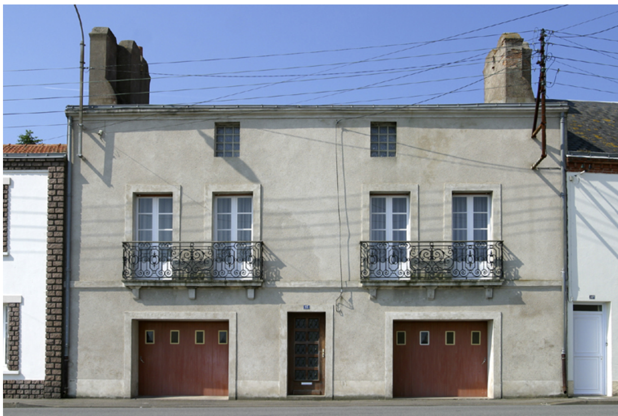
Vue d'ensemble de la façade antérieure.
