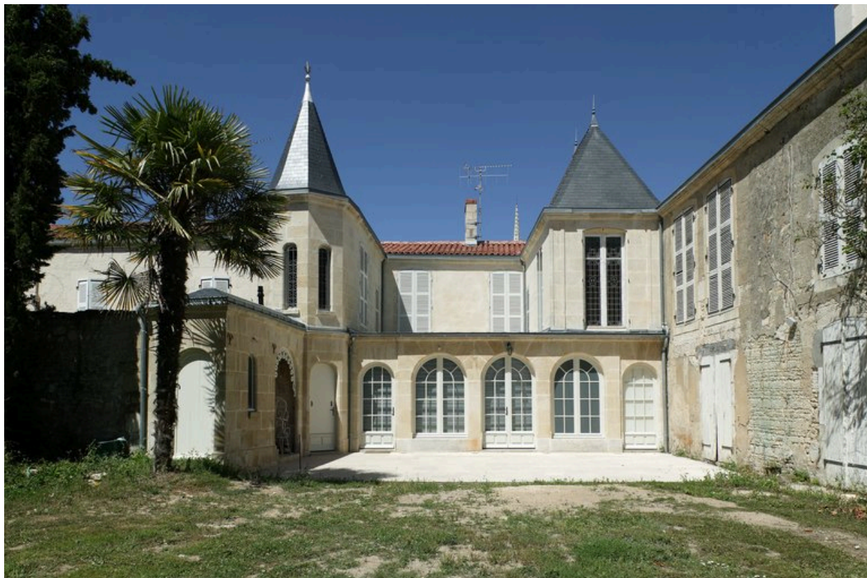
Partie nord de la demeure, donnant sur le jardin. Le pavillon de droite contient l'escalier.
