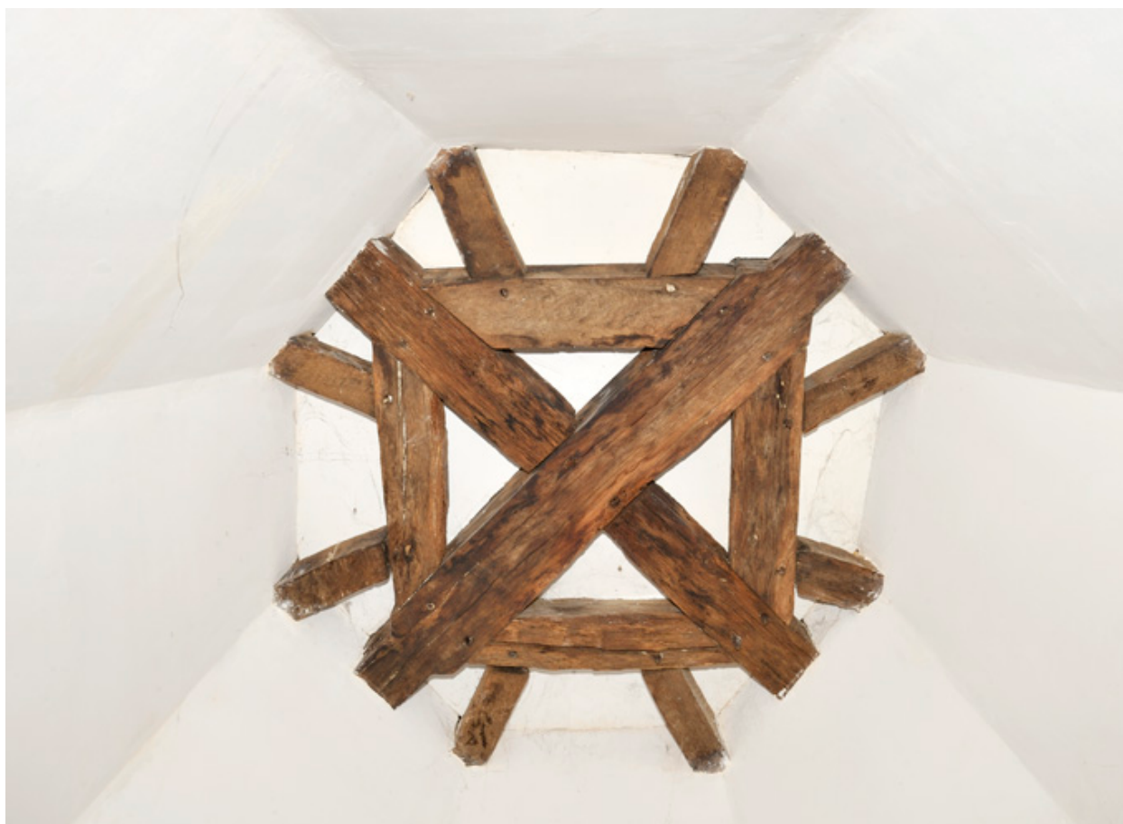
Tourelle d'escalier : enrayure haute de la charpente.
