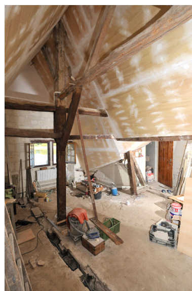
Charpente (vue vers le nord).
