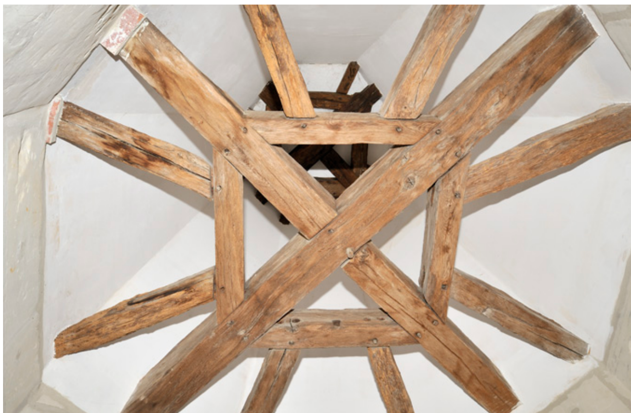
Tourelle d'escalier : enrayure basse de la charpente.
