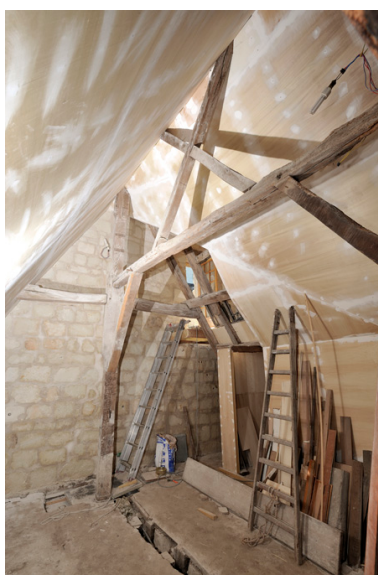
Charpente (vue vers le sud).
