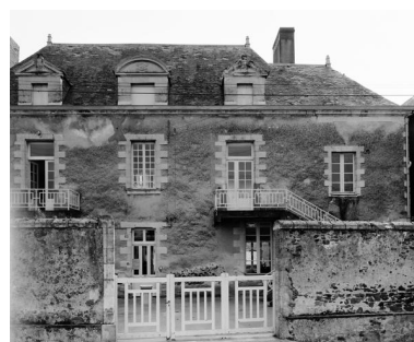
Façade antérieure de l'école de filles. Phot. Bruno Rousseau IVR52_19854901622V
