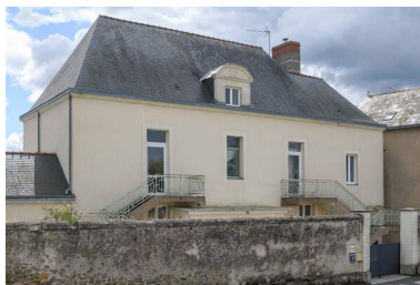
Vue d'ensemble de la façade principale. Phot. Armelle Maugin IVR52_20244900868NUCA
