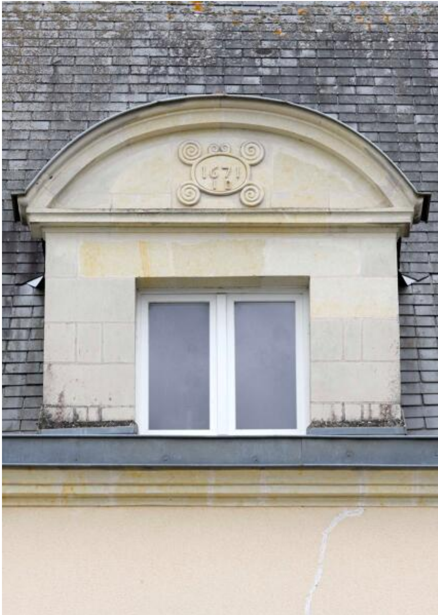
Détail du fronton de la lucarne centrale, date portée de 1671.
