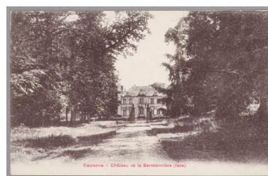
Château de la Bermondière, façade sur cour. Carte postale, vers 1900. Repro. Allison Haugmard IVR52_20235300011NUCA
