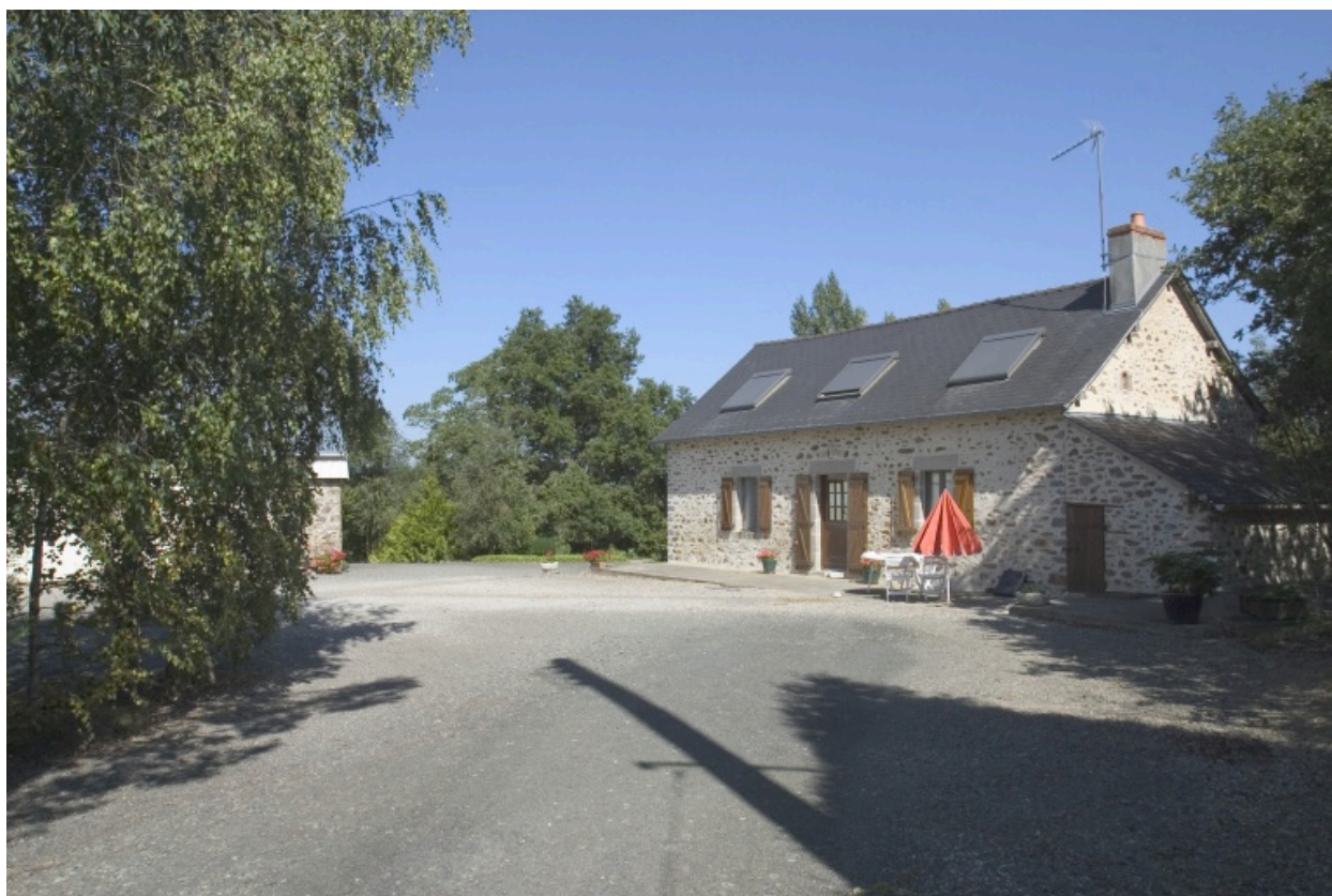
Le logis vu depuis l'entrée au sud-ouest. A gauche, l'étable.
