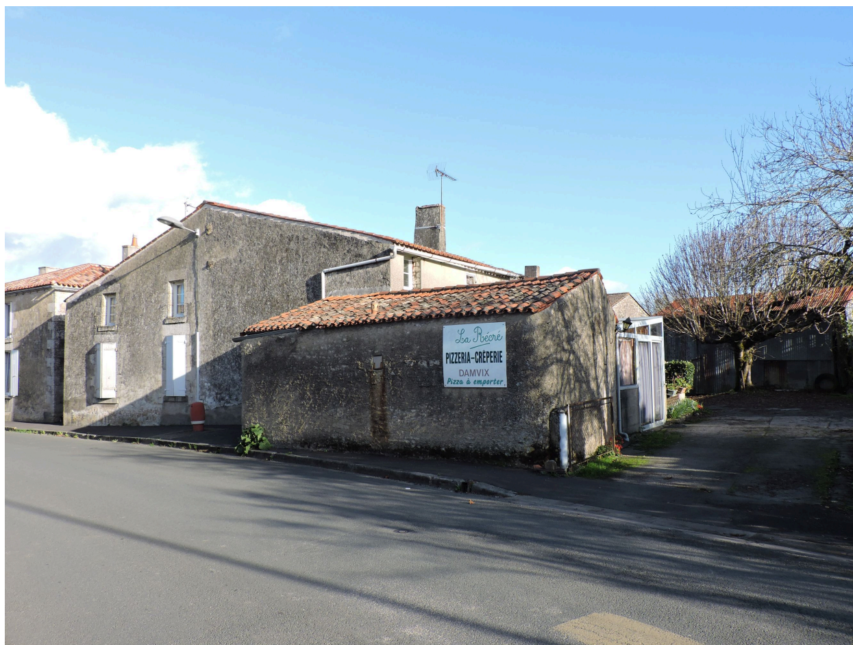
Le logis vu depuis l'ouest.
