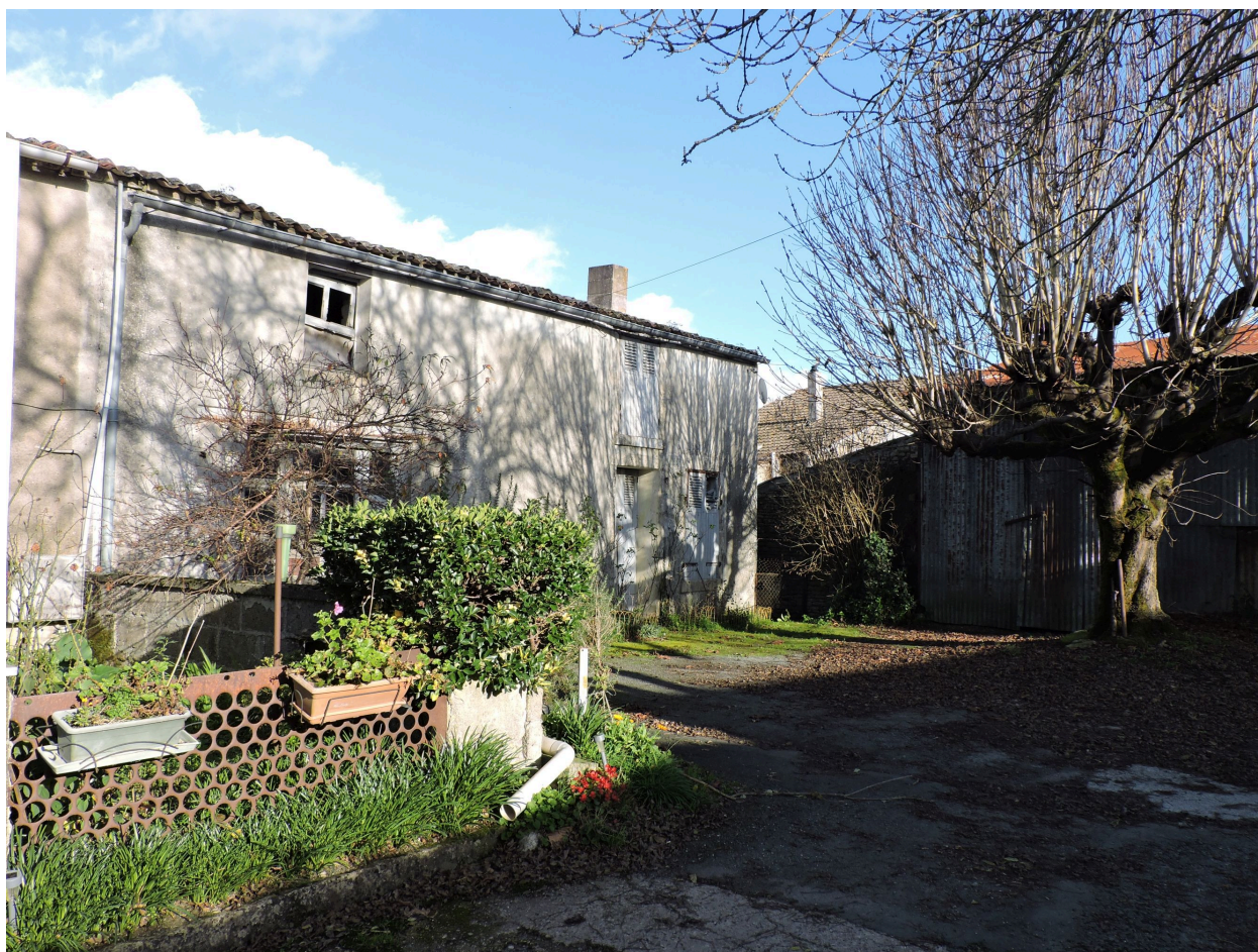
Le logis vu depuis l'ouest.
