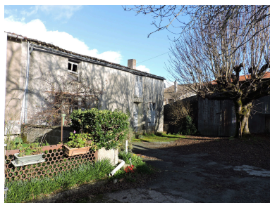
Le logis vu depuis l'ouest. Phot. Yannis Suire IVR52_20218500896NUCA
