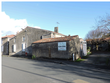
Le logis vu depuis l'ouest. Phot. Yannis Suire IVR52_20218500894NUCA
