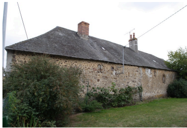
La façade postérieure du 4 rue du Bas-Château vue depuis la rue. L'ancienne ferme occupe la partie droite du corps de bâtiment.
