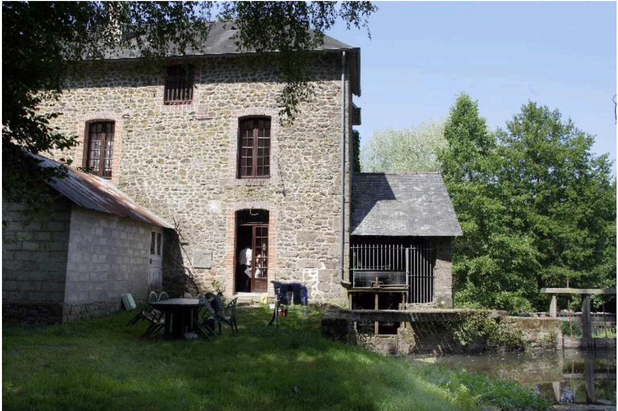
Le moulin vu depuis l'amont à l'est.
