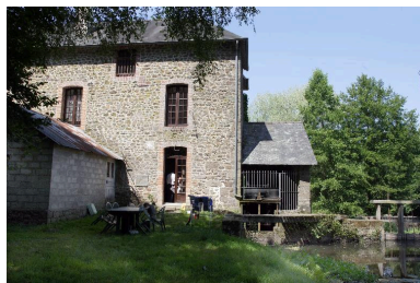
Le moulin vu depuis l'amont à l'est. Phot. François Lasa IVR52_20055300389NUCA
