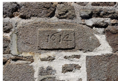
Détail de la façade postérieure du moulin : date portée. Phot. François Lasa IVR52_20055300391NUCA
