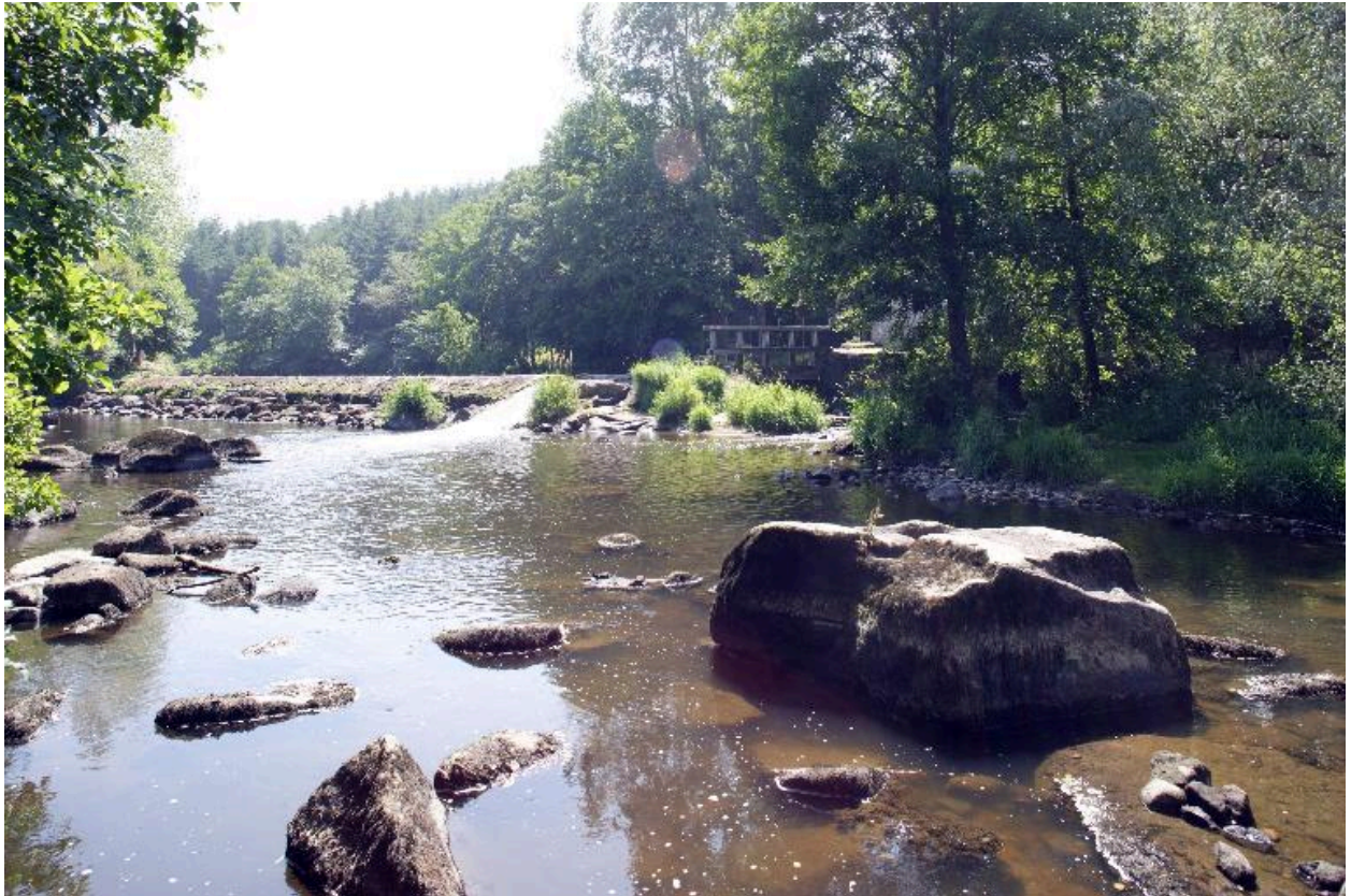
Le barrage vu depuis l'aval à l'ouest.
