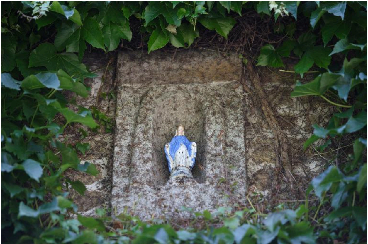
Détail de la façade principale du moulin : la niche portant la date de 1891.
