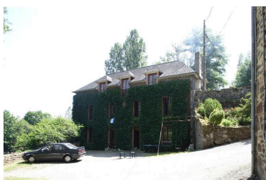
Le moulin vu depuis la cour à l'ouest. Phot. François Lasa IVR52_20055300384NUCA
