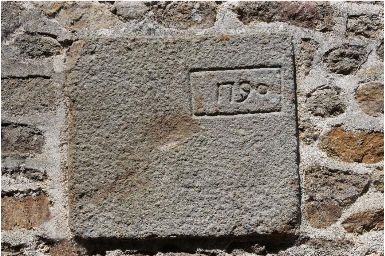
Détail de la façade postérieure du moulin : date portée.
