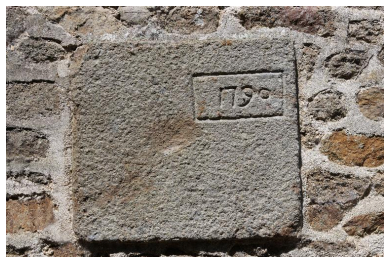
Détail de la façade postérieure du moulin : date portée. Phot. François Lasa IVR52_20055300390NUCA
