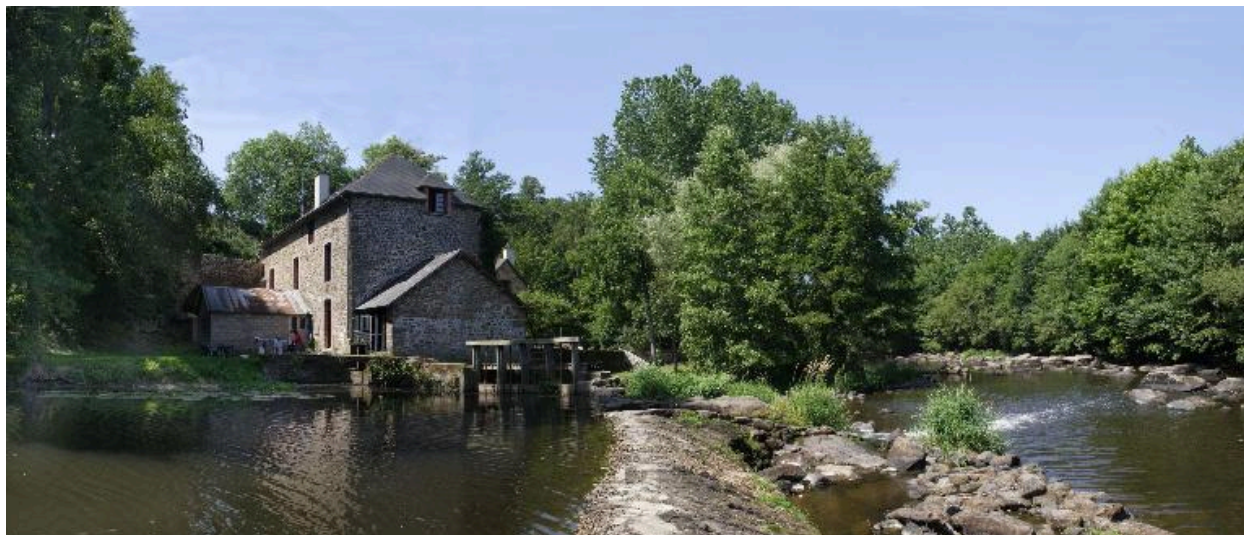
Vue d'ensemble depuis le barrage au nord-est.
