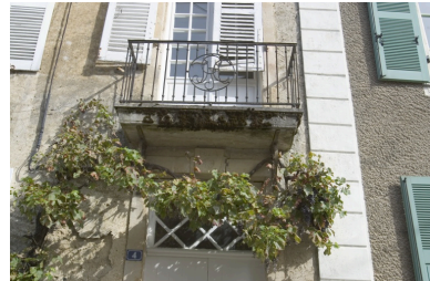
Détail de la façade : le balcon et la date portée. Phot. François Lasa IVR52_20045303131NUCA
