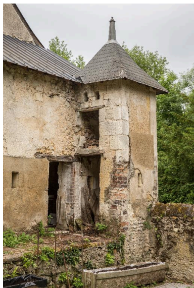
Tourelle dotée de deux trous de boulin. Phot. Pierre-Bernard Fourny IVR52_20187200573NUCA
