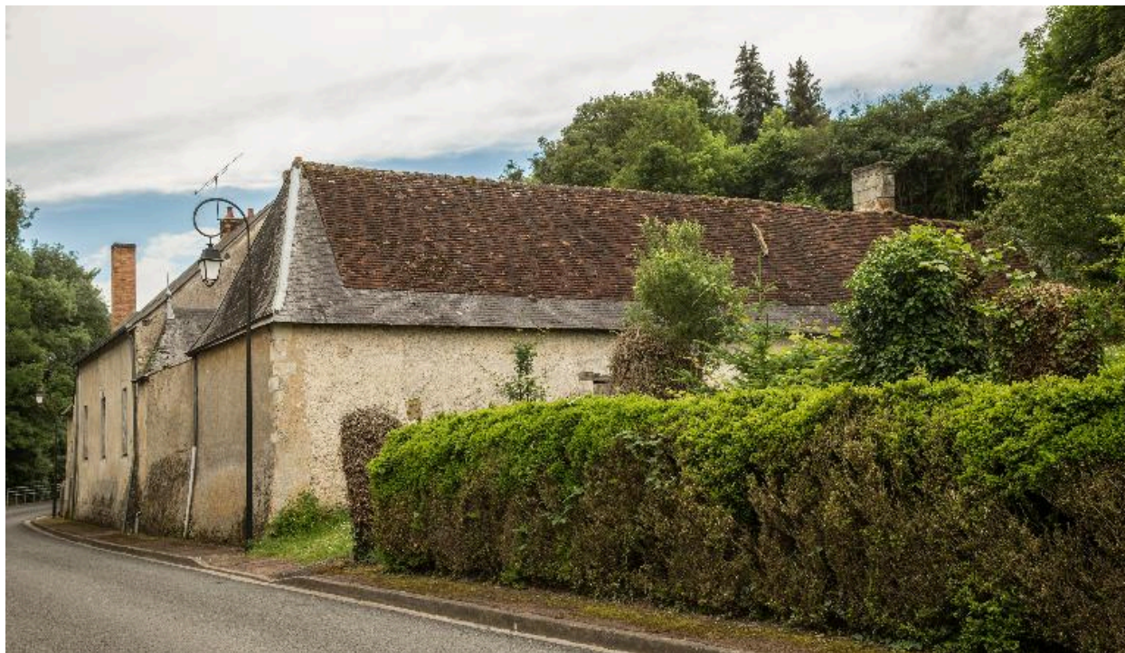
Vue prise depuis la rue : grange-étable en premier plan, perpendiculaire au coteau.
