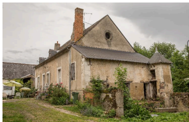
Le logis, façade sur cour, et les soues. Phot. Pierre-Bernard Fourny IVR52_20187200571NUCA
