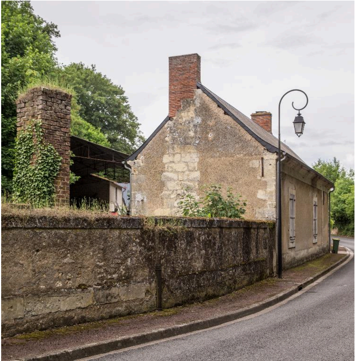
Logement, vu depuis la rue.
