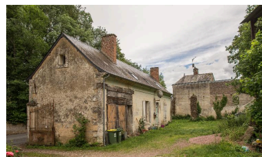
Logement et remise, façade sur cour. Phot. Pierre-Bernard Fourny IVR52_20187200572NUCA
