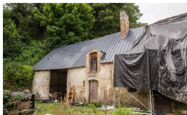
Grange-étable à fenil et logement perpendiculaires au coteau. Phot. Pierre-Bernard Fourny IVR52_20187200570NUCA
