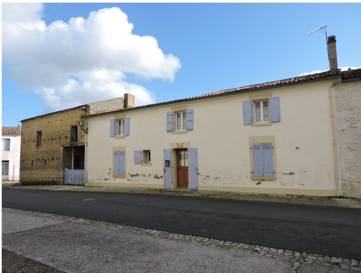
L'ancienne ferme vue depuis le nord-ouest.
