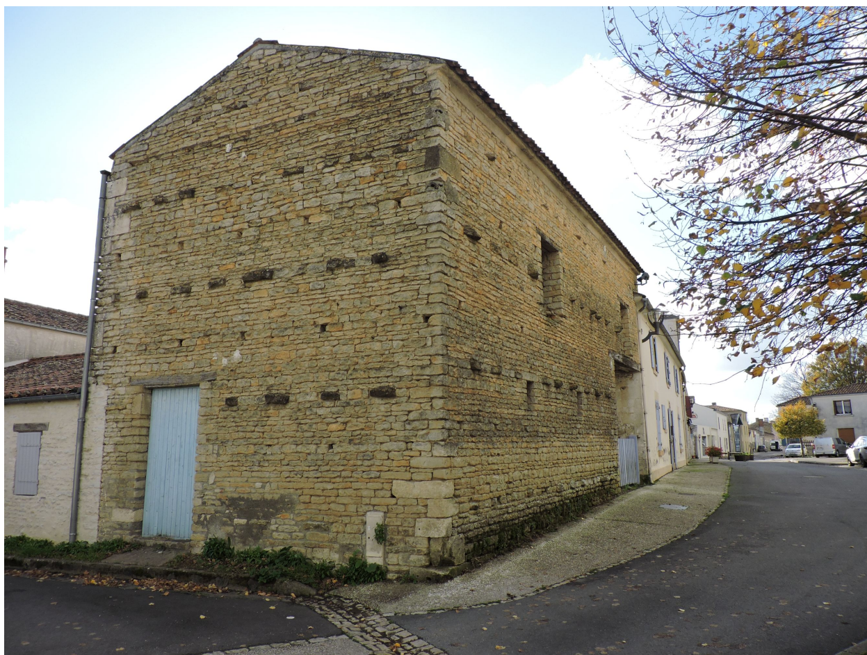
Les dépendances vues depuis le nord-est.
