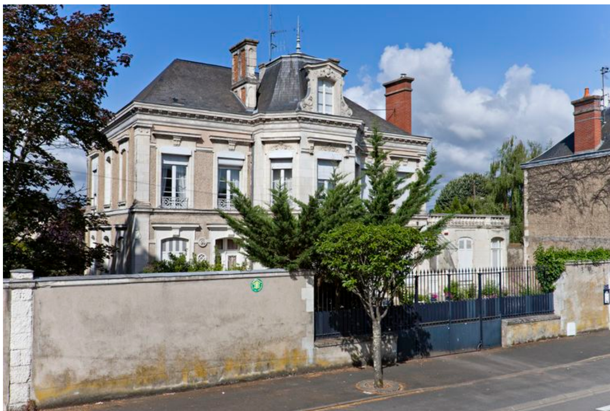
Vue d'ensemble prise du boulevard : mur de cloture et grille.
