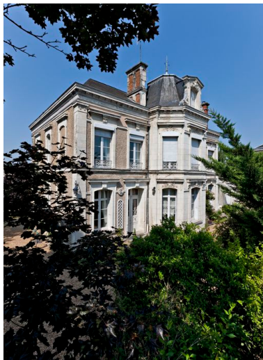
Vue de volume prise dans la cour. Phot. Yves Guillotin IVR52_20137200888NUCA
