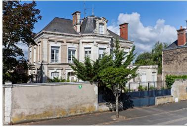
Vue d'ensemble prise du boulevard : mur de clôture et grille. Phot. Yves Guillotin IVR52_20117200818NUCA
