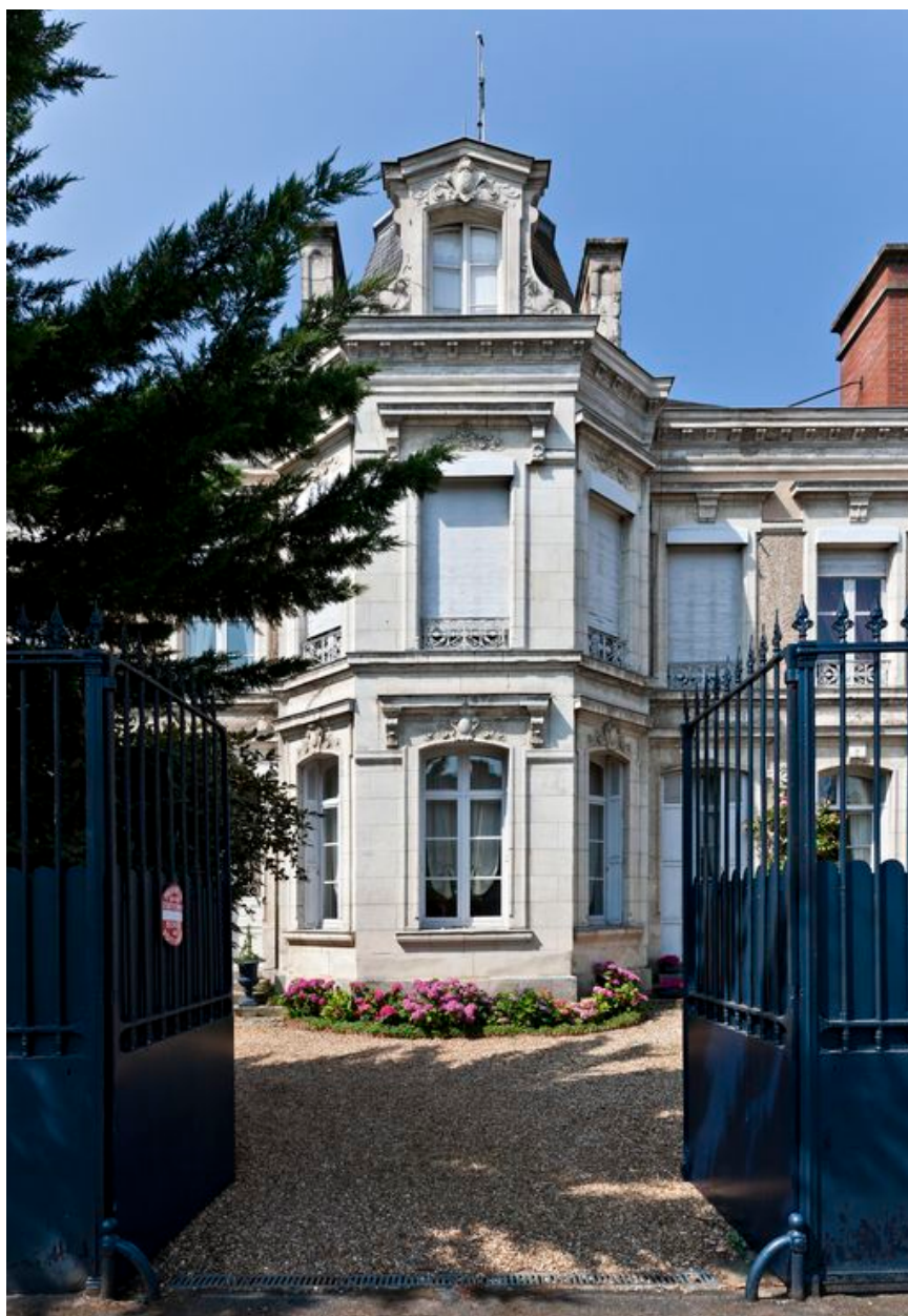
Façade antérieure sur cour : pavillon central.
