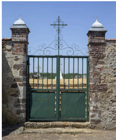
Le portail principal. Phot. Pierre-Bernard Fourny IVR52_20197201608NUCA
