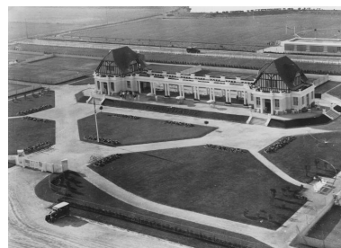
Vue aérienne à l'est du Tennis Club de La Baule avec en arrière-plan le stand de tir aux pigeons. Phot. François Lasa IVR52_19934401152X
