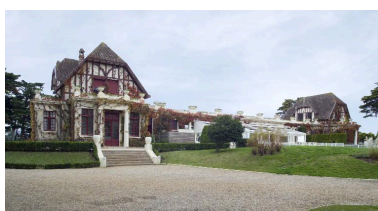
Vue d'ensemble du Tennis Country Club. Phot. Denis (reproduction) Pillet IVR52_20044403048NUCA
