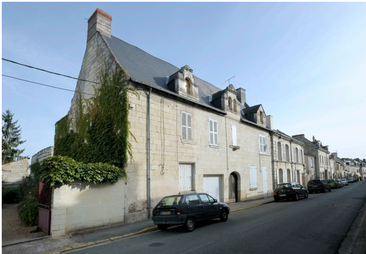
Vue d'ensemble sur le logis et la rue Robert d'Arbrissel..
