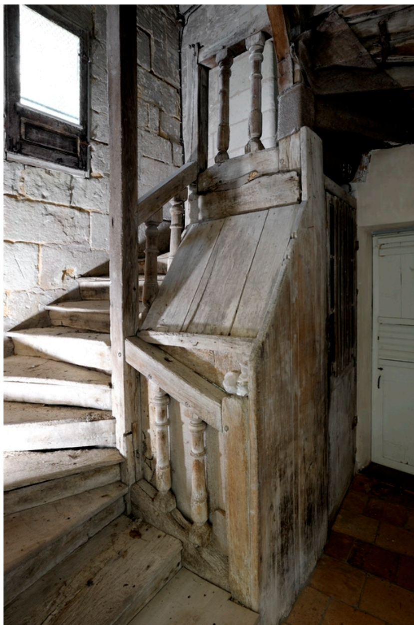
Escalier tournant suspendu, en charpente et à balustres tournés (2e moitié XVIIIe siècle).
