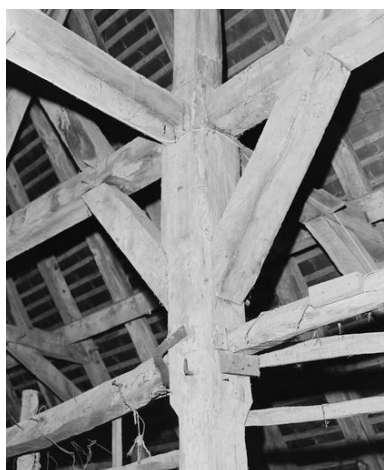
Comble. Charpente, détail du poinçon, portant faux-entraits et contreventement ; arrière- plan : détail de la panne sur encoche dans le faux-entrait. Phot. Bruno Rousseau IVR52_19964900566X
