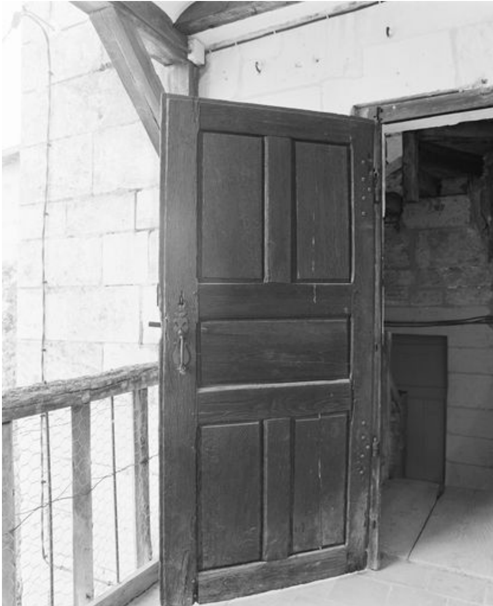
Huisseries (fin XVIIe ou XVIIIe siècle ?). Etage-carré, porte de la tourelle d'escalier ouvrant sur la galerie extérieure.
