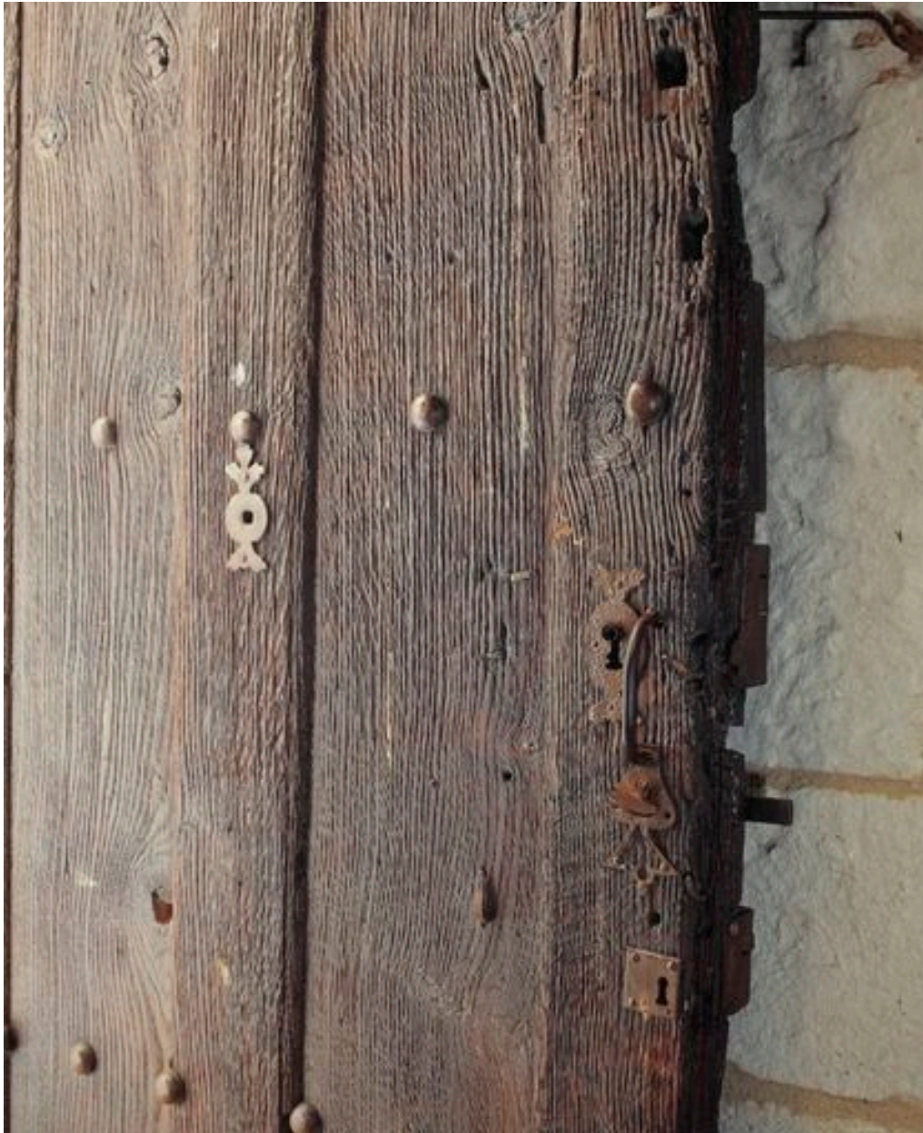
Huisseries (fin XVIIe ou XVIIIe siècle ?). Entrée sur rue, porte bâtarde, revers sous le passage couvert, détail des ferrures et serrure (3).
