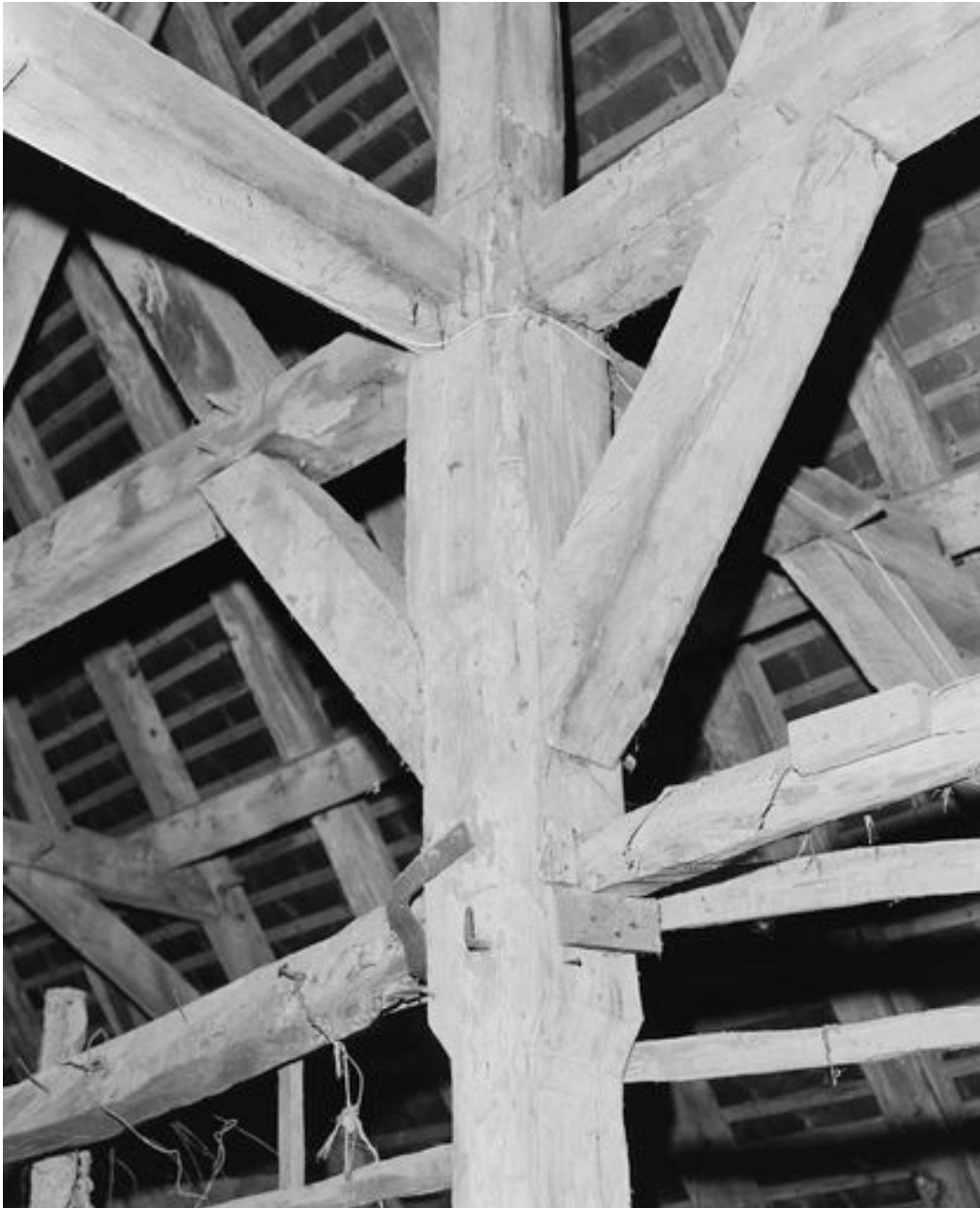
Comble. Charpente, détail du poinçon, portant faux-entrants et contreventement ; arrière-plan : détail de la panne sur encoche dans le faux-entrait.
