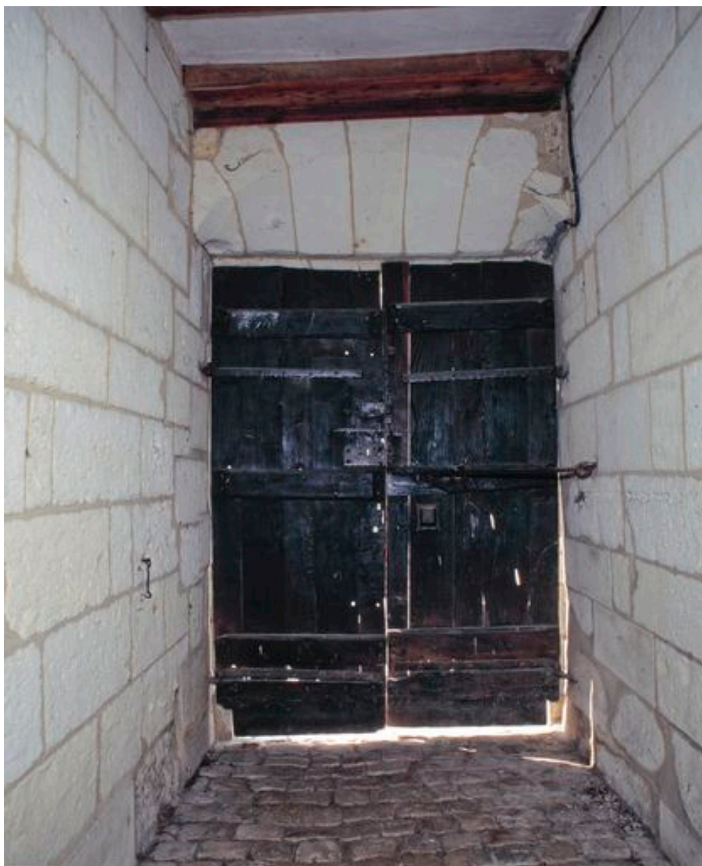
Huisseries (fin XVIIe ou XVIIIe siècle ?). Entrée sur rue, porte bâtarde, revers sous le passage couvert.
