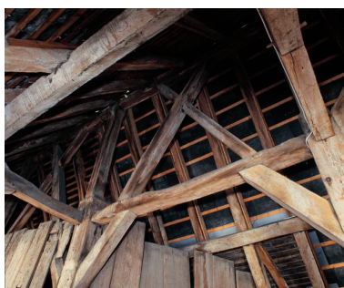
Comble. Charpente, détail du contreventement, à faitage, sous-faitage, liens en croix de Saint-André et aisseliers. Phot. Bruno Rousseau IVR52_19964900564XA
