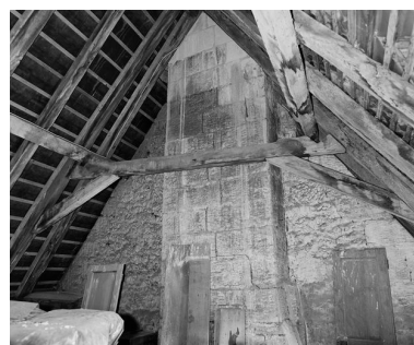
Comble. Charpente, détail de l'assemblage des pannes sur la ferme latérale. Phot. Bruno Rousseau IVR52_19964900560X
