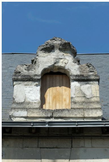
Lucarne latérale (ouest), à baie en plein-cintre et amortissement à volutes. Phot. Bruno Rousseau IVR52_20134900508NUCA
