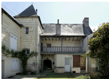
Façade postérieure, sur cour, avec tourelle d'escalier et galerie en charpente de distribution extérieure. Phot. Bruno Rousseau IVR52_20134900509NUCA
