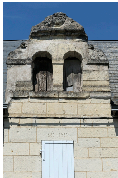
Lucarne axiale à baies jumelées couvertes en plein-cintre et amortissement à volutes, portant la date de 1583. Phot. Bruno Rousseau IVR52_20134900507NUCA
