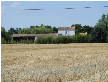
L'ancienne ferme vue depuis l'est. Phot. Yannis Suire IVR52_20188501234NUCA
