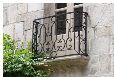
Façade sur rue, détail d'un balconnet. Phot. Denis Pillet IVR52_20074401101NUCA
