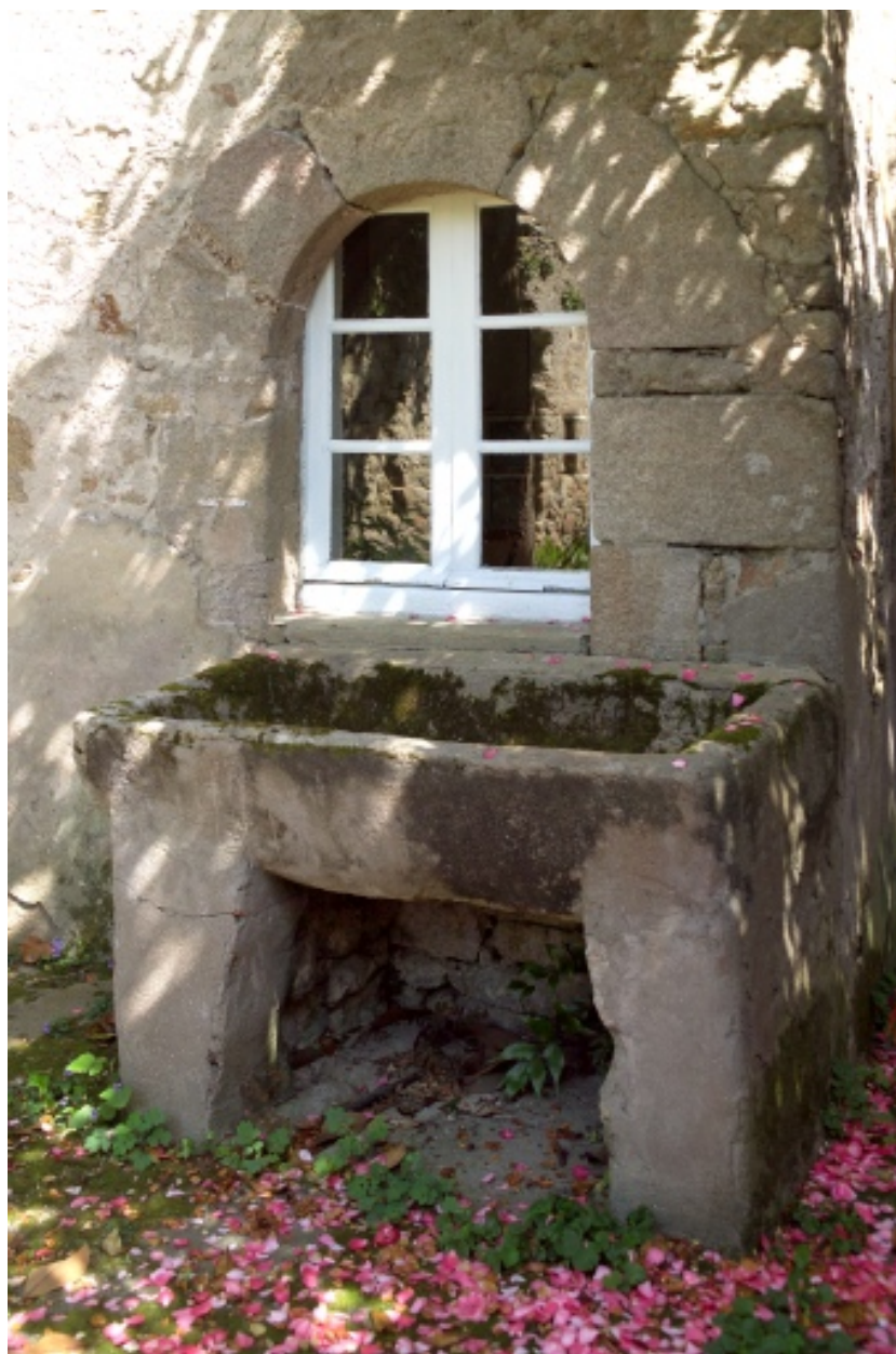
Détail de la fenêtre recevant l'évier.
