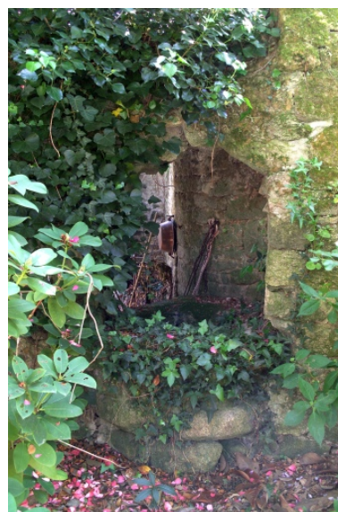
Vue du puits mitoyen. Phot. Denis Pillet
