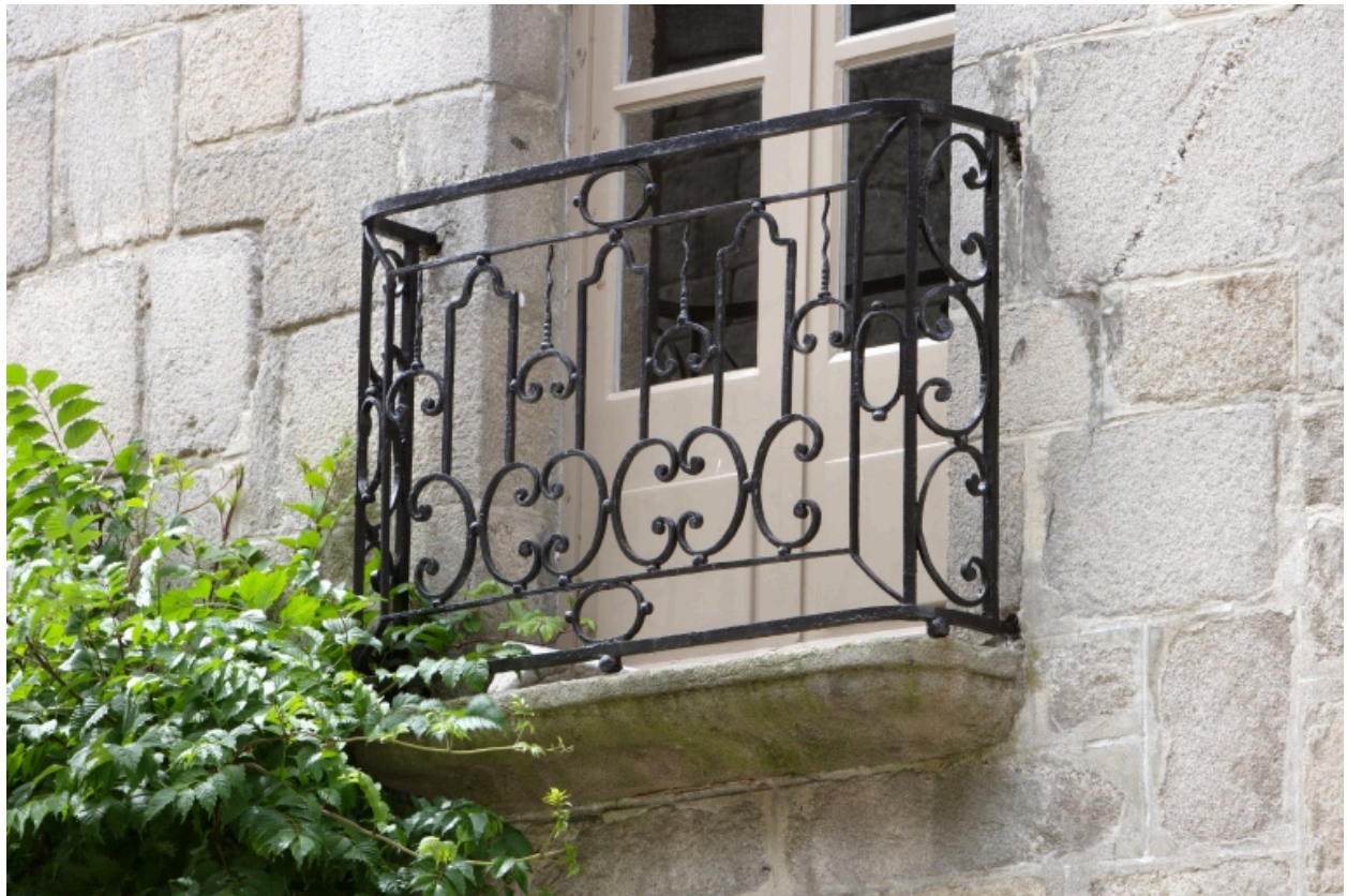
Façade sur rue, détail d'un balconnet.
