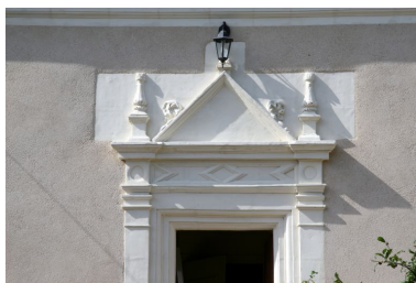
Façade antérieure : porte d'entrée. Phot. Jean-Baptiste Darrasse IVR52_20077201518NUCA
