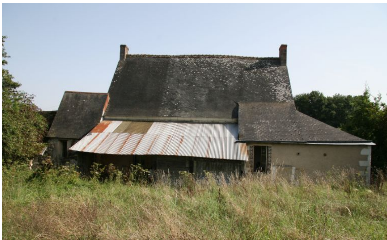
Vue de volume prise du nord.
