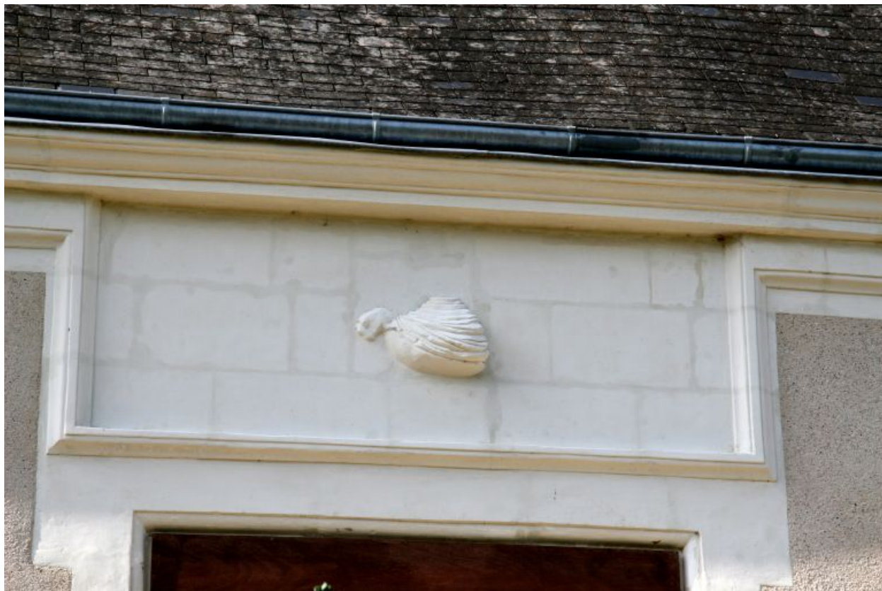
Façade antérieure, décor sculpté : vestige du buste d'une femme (épouse du maître d'ouvrage ?).
