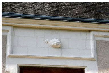
Façade antérieure, décor sculpté : vestige du buste d'une femme (épouse du maître d'ouvrage ?). Phot. Jean-Baptiste Darrasse IVR52_20077201525NUCA
