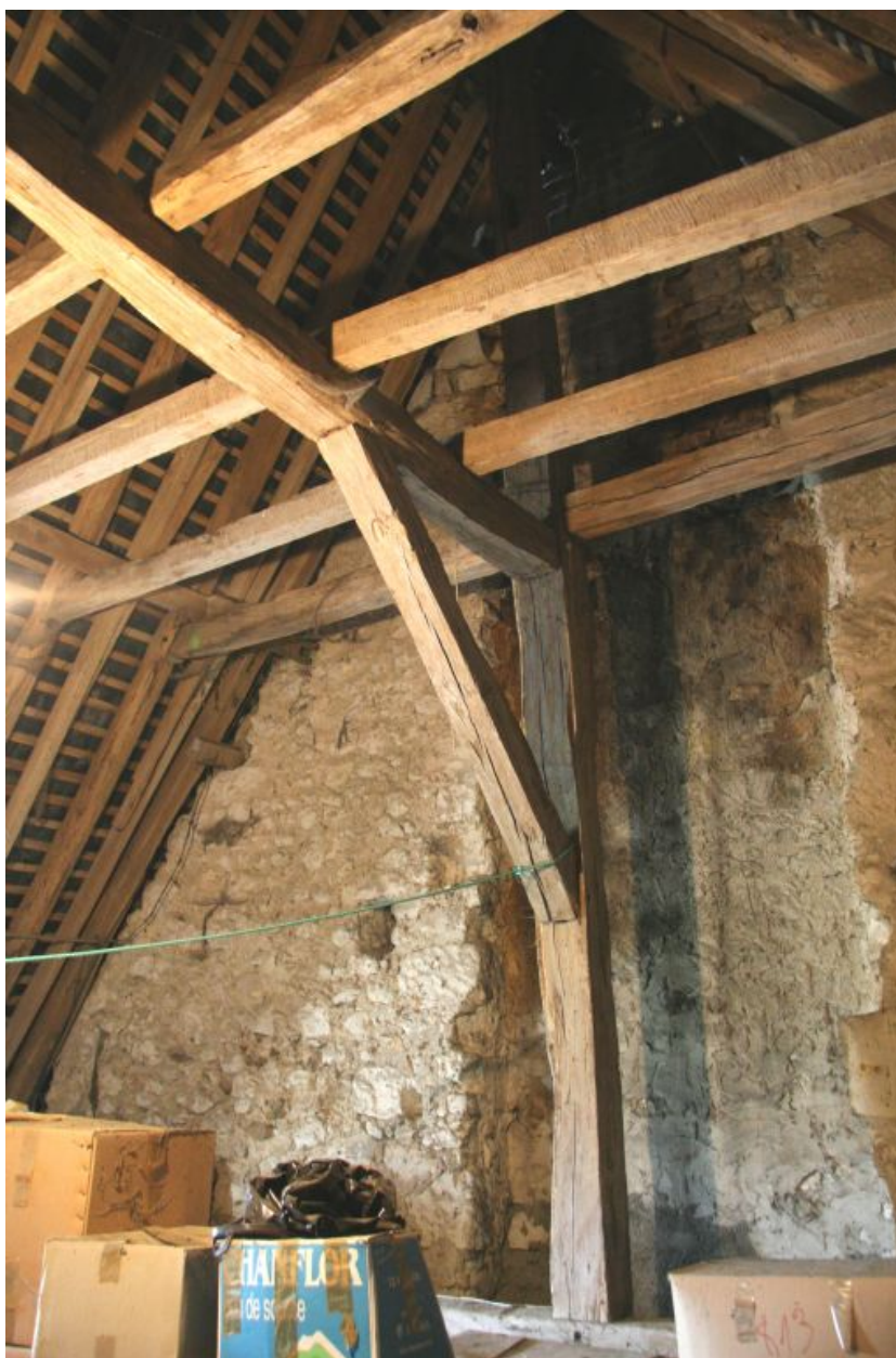
Charpente de la maison : poinçon.
