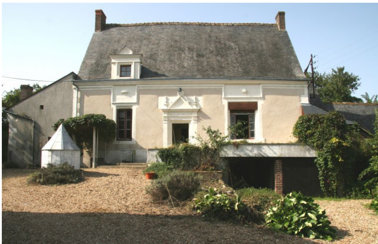
Façade antérieure sur cour.
