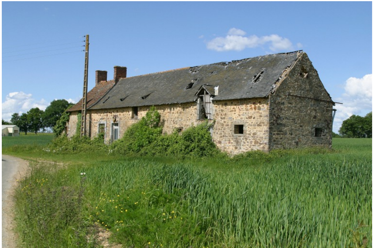
Le logis-étable vu du sud.
