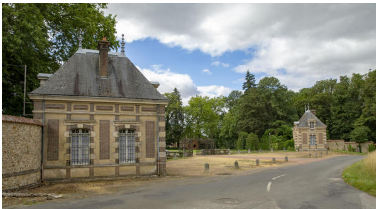
Les pavillons d'entrée du château de la Pierre.
