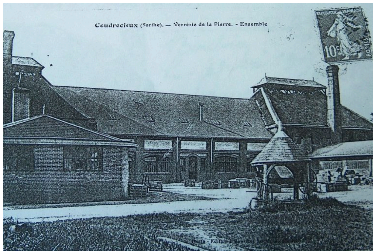
Elévation antérieure de la verrerie.
