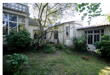
Vue de la maison de René Viau depuis le jardin. Phot. Bruno Rousseau, Phot. Youenn Communeau IVR52_20114901391NUCA
