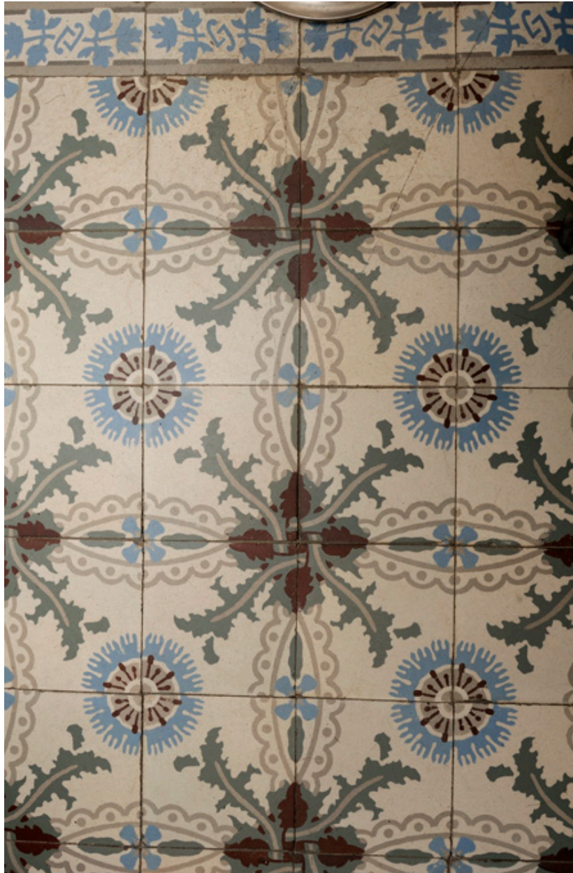
Maison de René Mary : exemple de carrelage d'origine, situé dans les pièces de réception.
