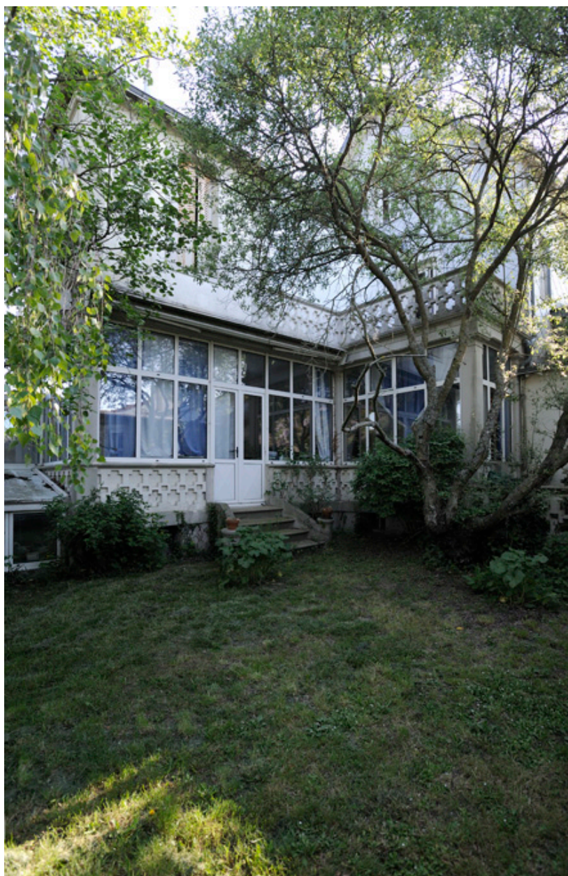
Maison de René Viau : serre et véranda.
