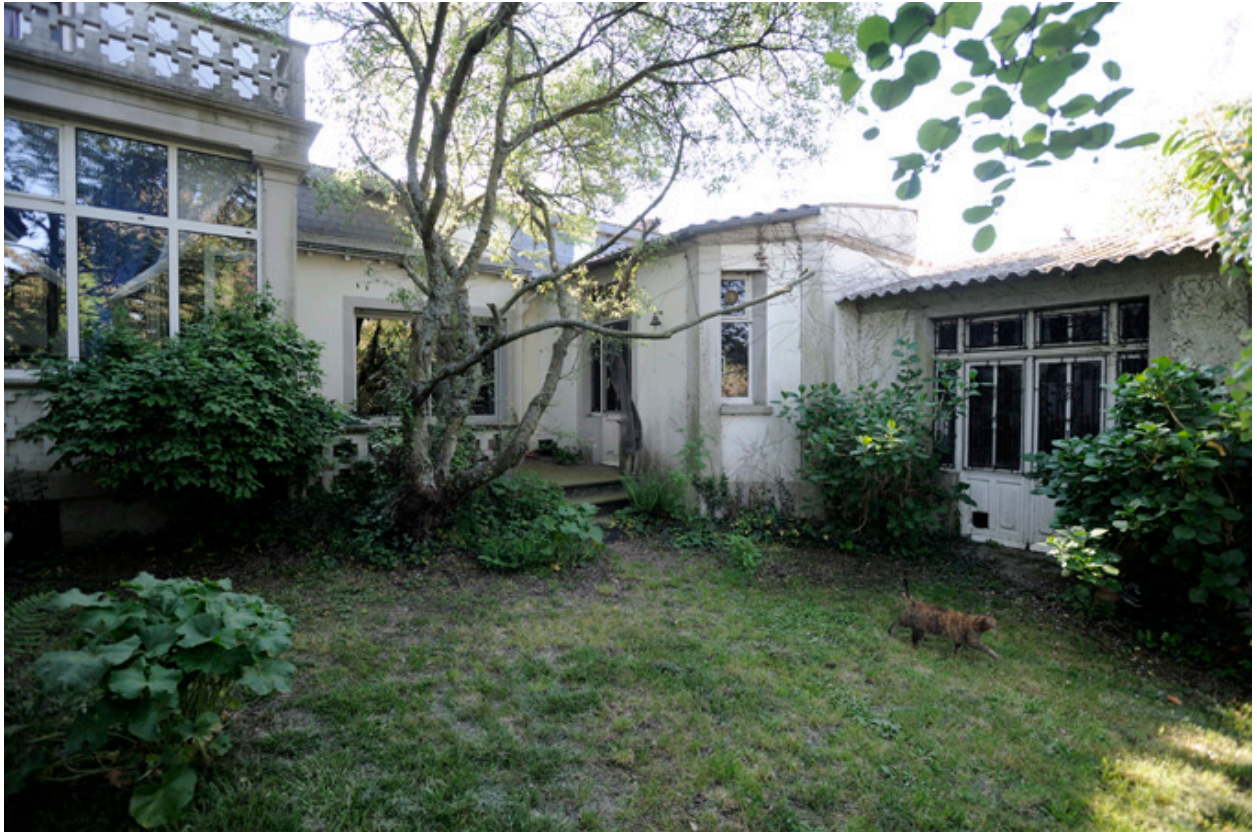
Vue de la maison de René Viau depuis le jardin.
