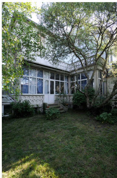
Maison de René Viau : serre et véranda. Phot. Bruno Rousseau, Phot. Youenn Communeau IVR52_20114901392NUCA
