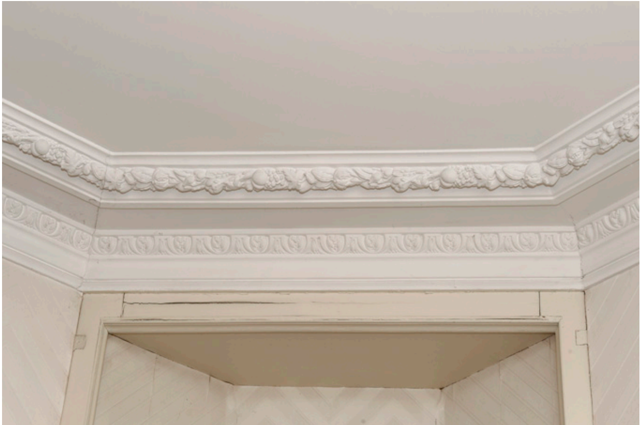
Maison de René Viau : détail d'un décor stucqué.
