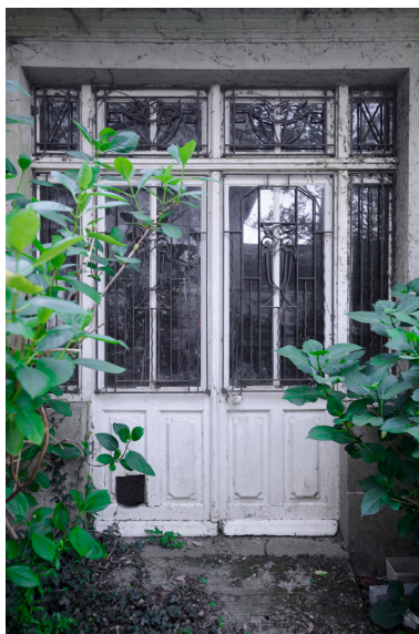
Maison de René Viau : porte de la buanderie. Phot. Bruno Rousseau, Phot. Youenn Communeau IVR52_20114901397NUCA
