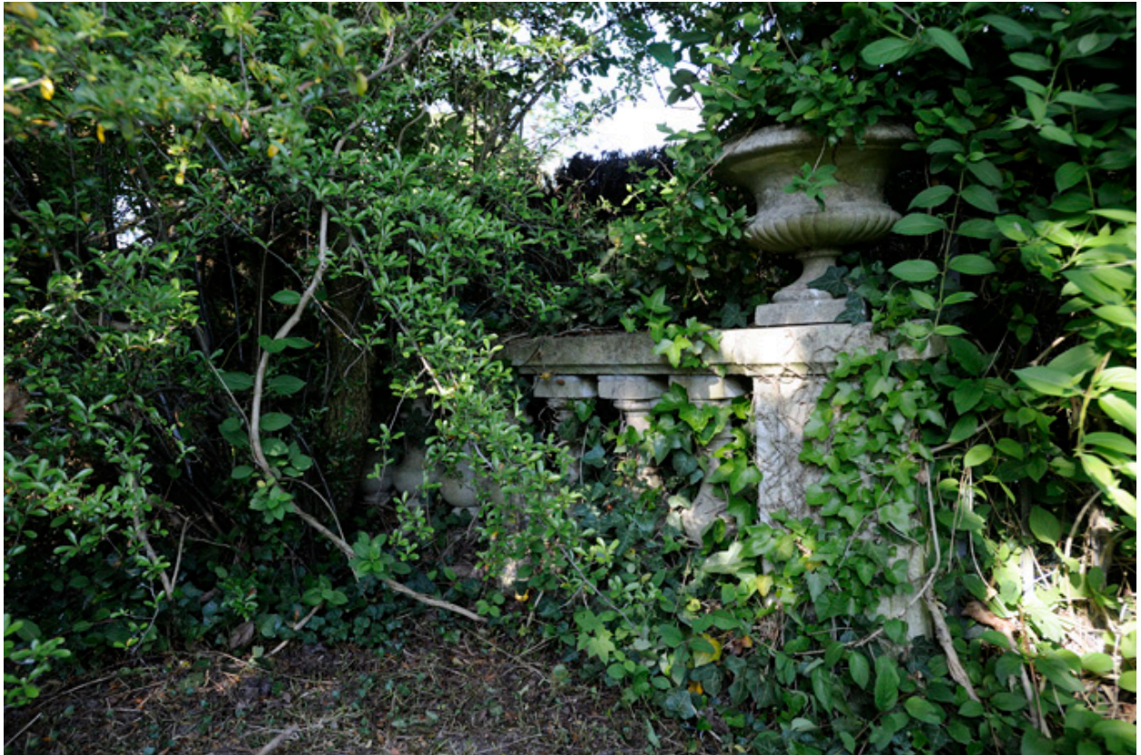
Maison de René Viau : balustrade, qui marquait la séparation entre le jardin à la française et le reste du parc.
