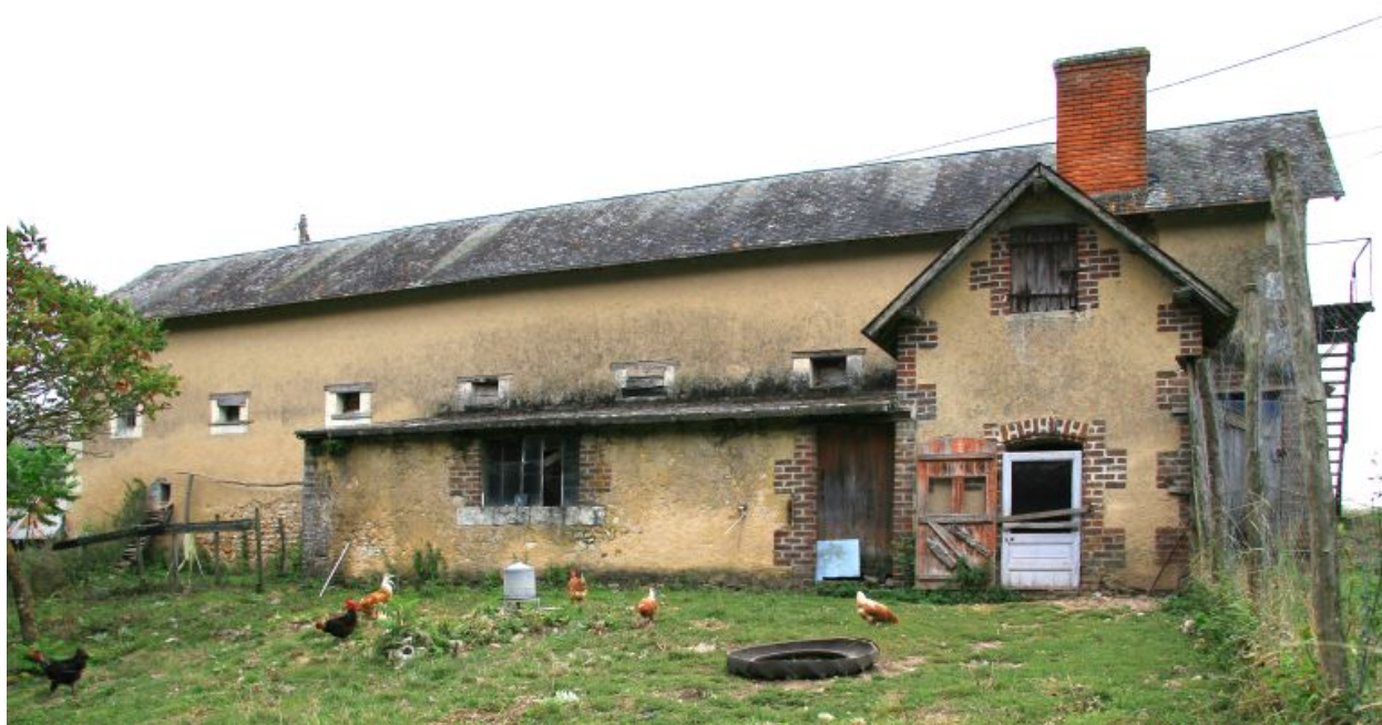
Les toits à porcs et la buanderie : façade postérieure.
