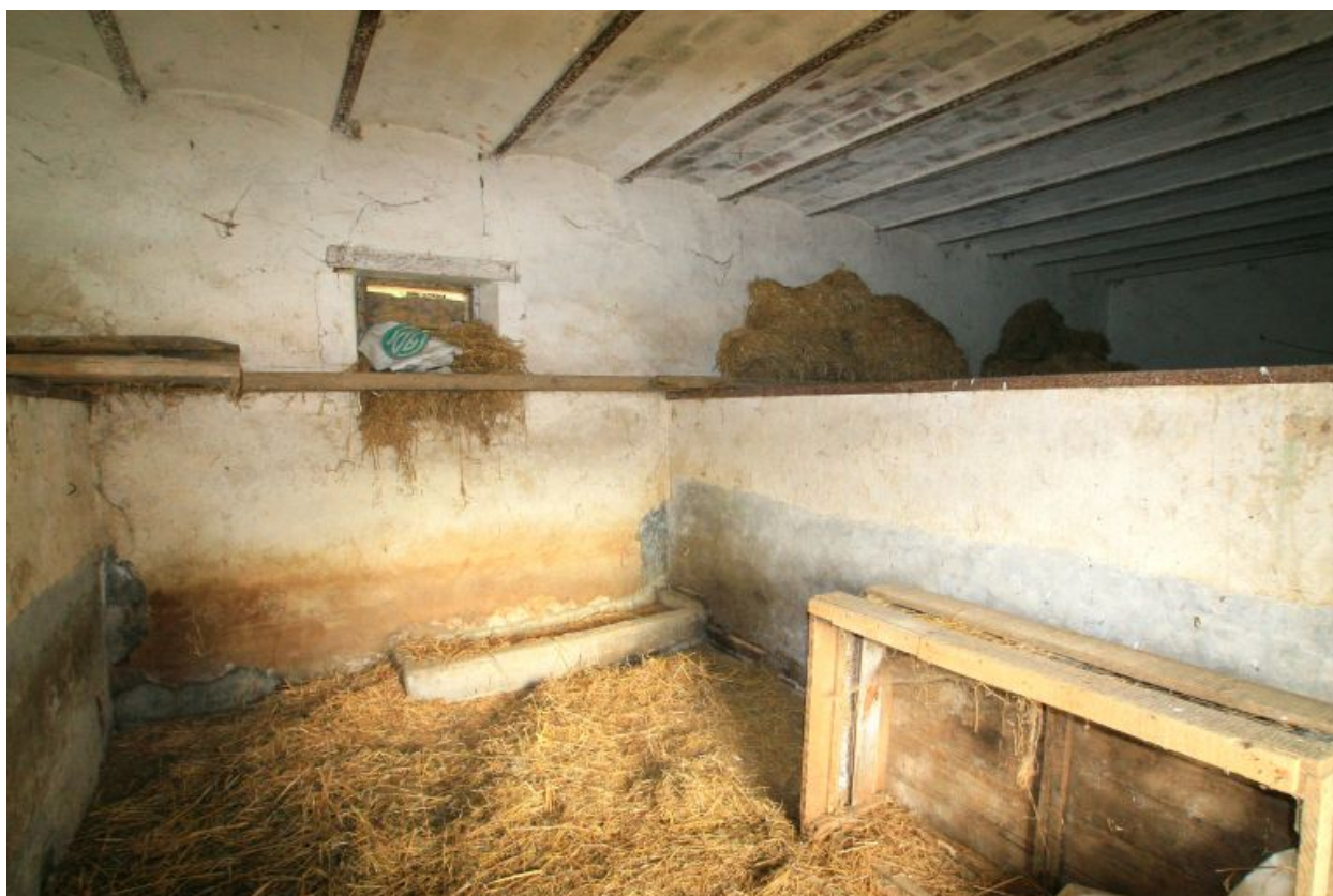
Soue à cochons : plafond avec entrevous.
