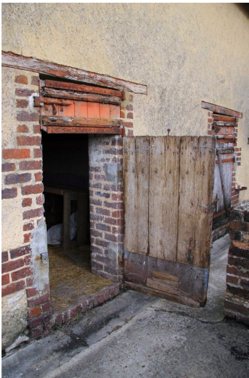
Les portes d'entrée de la buanderie et de la cour des porcs.
