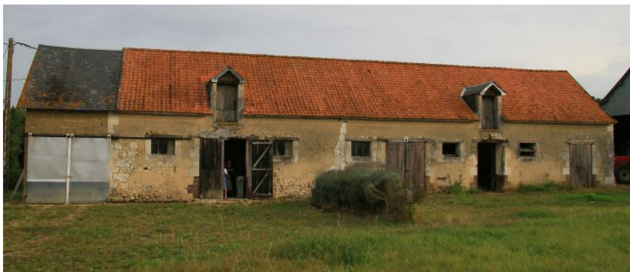
La grange et les étables accolées.
