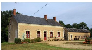
La maison : noter la composition symétrique de la façade avec la porte centrale. Phot. Jean-Baptiste Darrasse IVR52_20087202071NUCA
