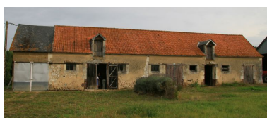
La grange et les étables accolées. Phot. Jean-Baptiste Darrasse IVR52_20087202073NUCA
